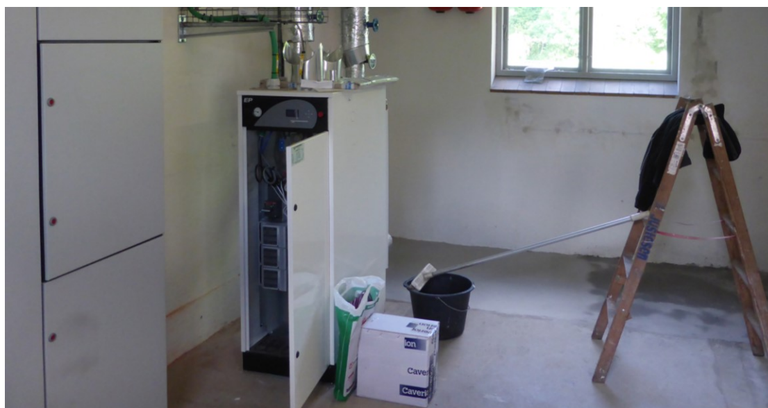
Figur 9 Elkedel installeres på Livø el- og varmeværk
