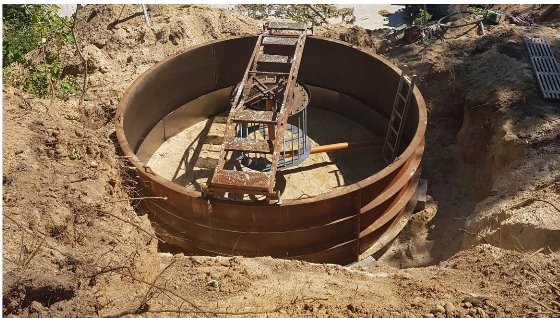
Figur 6 Støbeform til fundament på plads, maj 2018.
