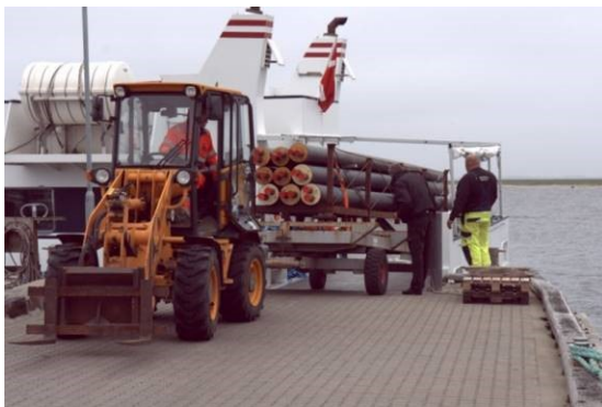
Fjernvarmerør køres i land.
