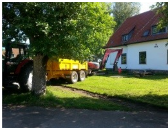
Anlægsarbejder i gang, juni 2016.
