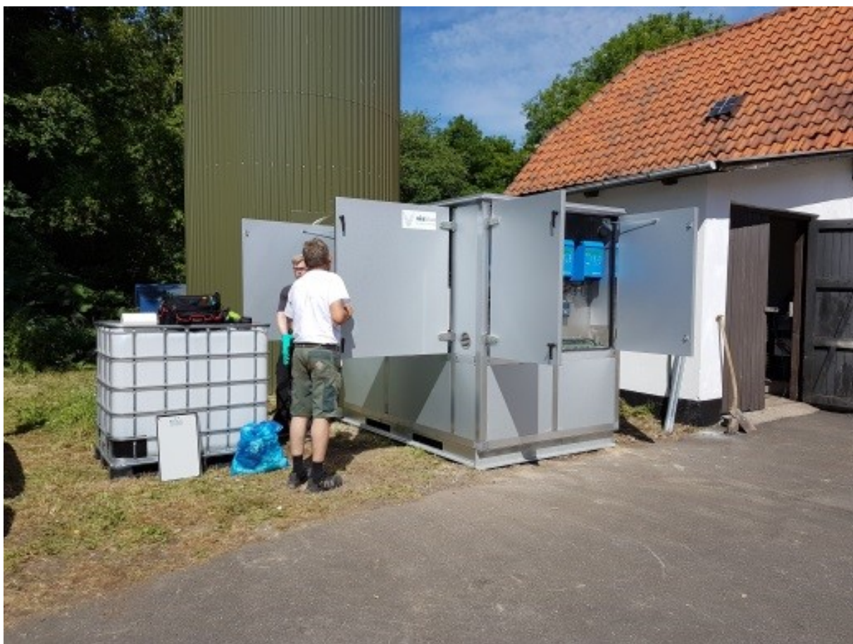
Figur 17 Batteriløsning på Livø. Installation af anlægget, juli 2018.
