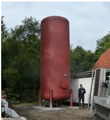
Tanken er nu placeret ved el- og varmegæret. Herefter kan isoleringsarbejdet gå i gang.
