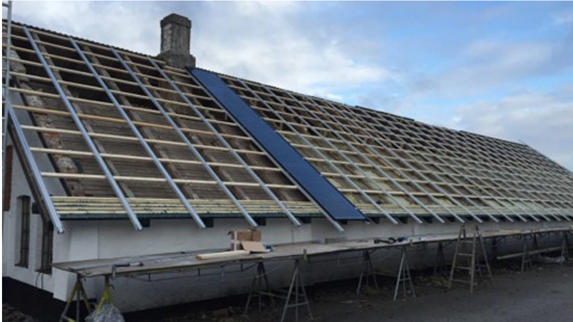
Figur 2 Etablering af solcelletag, november 2016.
