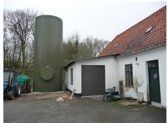
Den færdige tank. November 2016.
