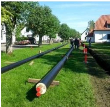
Anlægsarbejder i gang, juni 2016.
