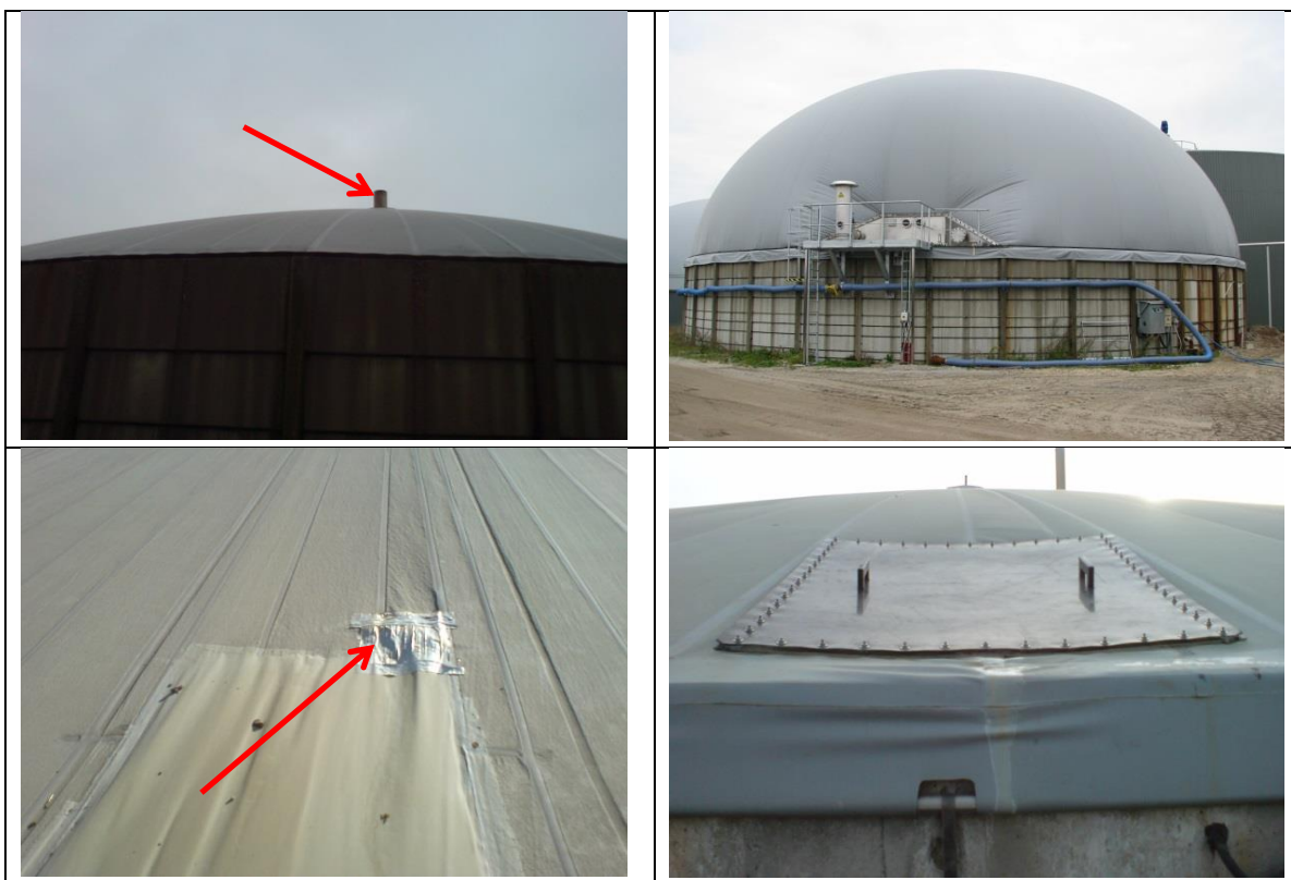
Figur 9. Eksempler på øvrige lækager og deres reparation. Øverste til venstre: Lækage ved mastetop på efterafgasningstank. Øverst til højre: Samme efterafgasningstank, men med ny membran. Nederst til venstre: Lækage i membran på efterafgasningstank. Membranen er forsøgt lappet med gaffatape. Nederst til højre: Samme efterafgasningstank, men med ny membran
