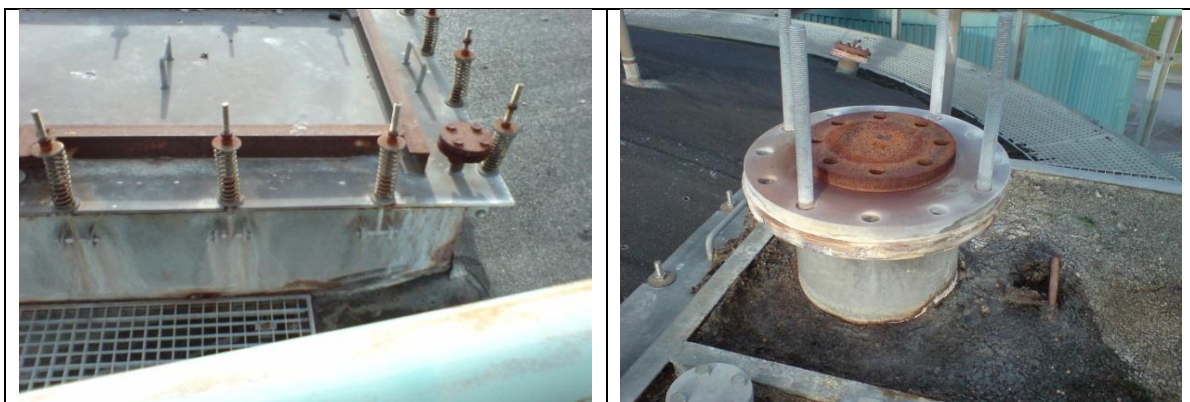
Figur 6. Eksemplar på springplader: Til venstre ses en ældre springplademodel, hvor tætningspladen holdes nede af forspændte fjedre. Til højre ses en simpel anordning til tryksikring, hvor flangen tætnet mod røråbning og kan løfte sig ved overtryk eller skumning
