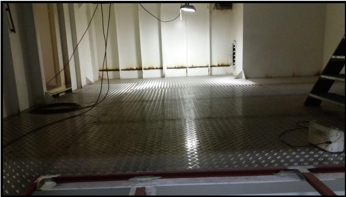
Billede 30) Dørk i maskinrum lagt
