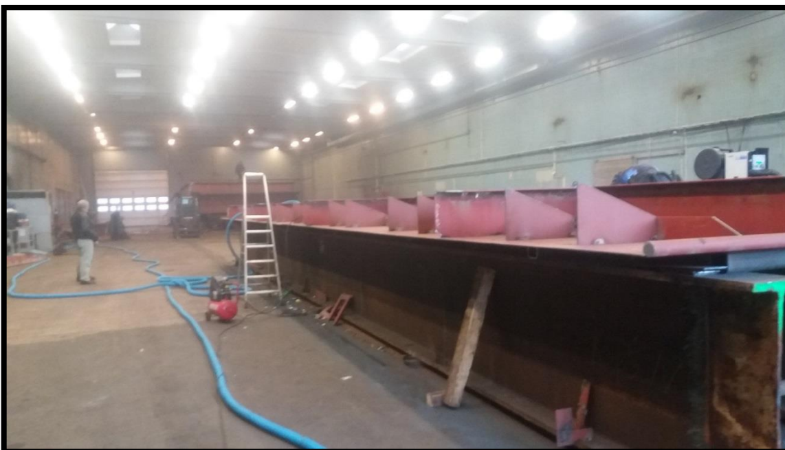
Billede 8) Webbjælker lagt på for pontonen, agter pontonen ses i baggrunden
