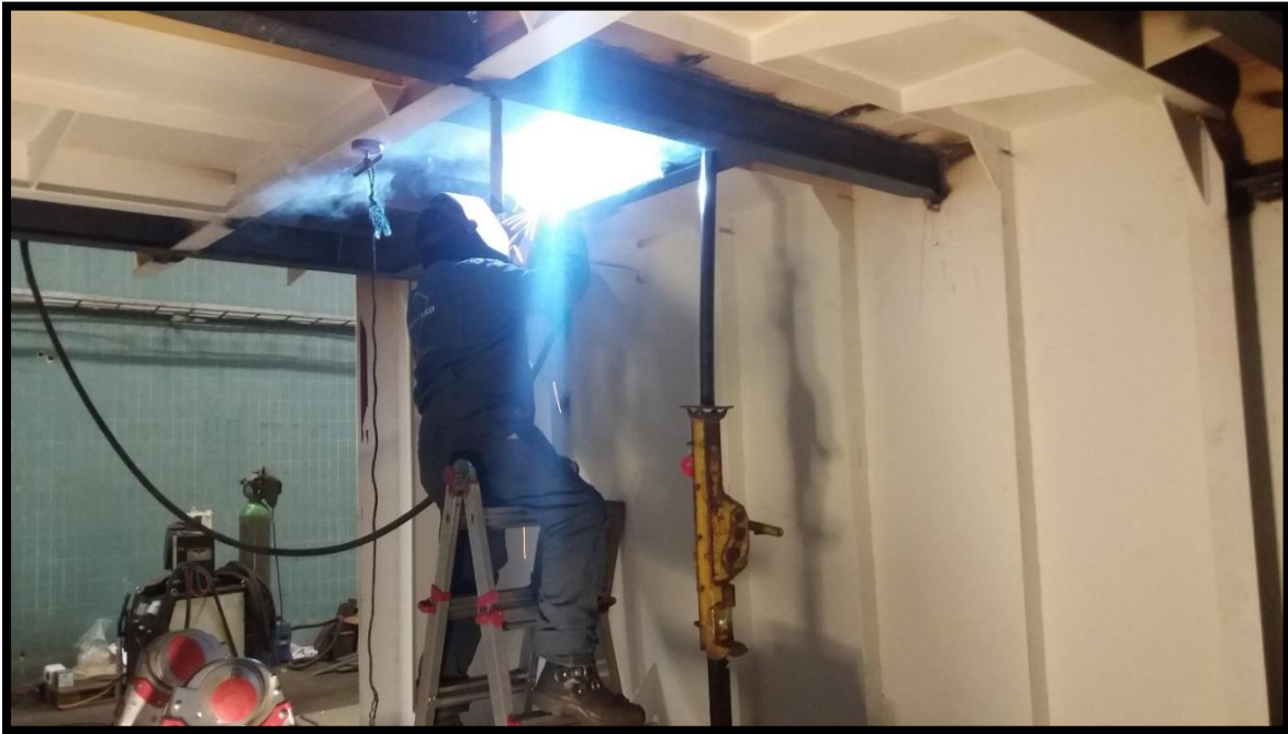
Billede 25) Forstærkning til PTO i svejses
