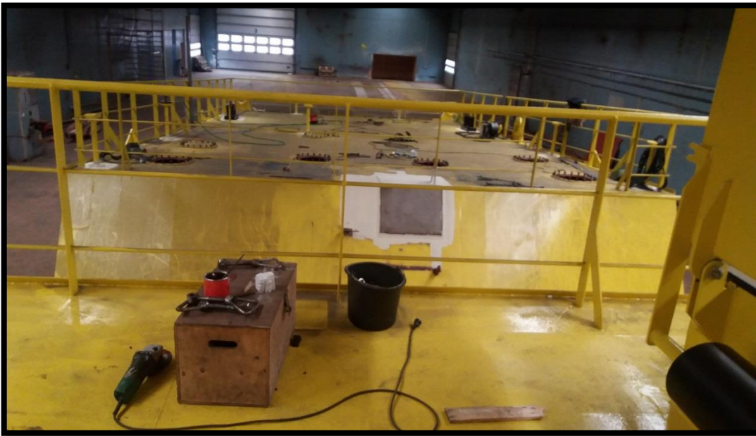
Billede 44) Forstærkning til trykstang isat
