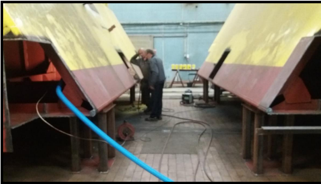
Billede 50) Der er skåret væk hvor forstærkningsplader skal indsættes
