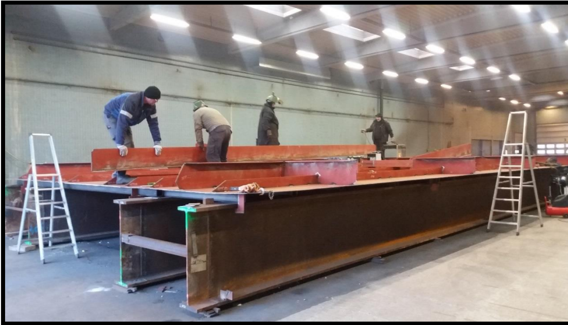
Billede 7) Køl, webbjælker bliver lagt på for pontonen
