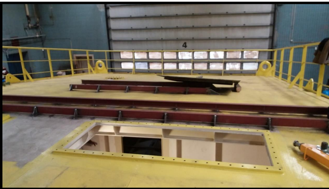
Billede 34) Dæk med serviceluge, skinner til løftebom, løfteøjer, klyds
