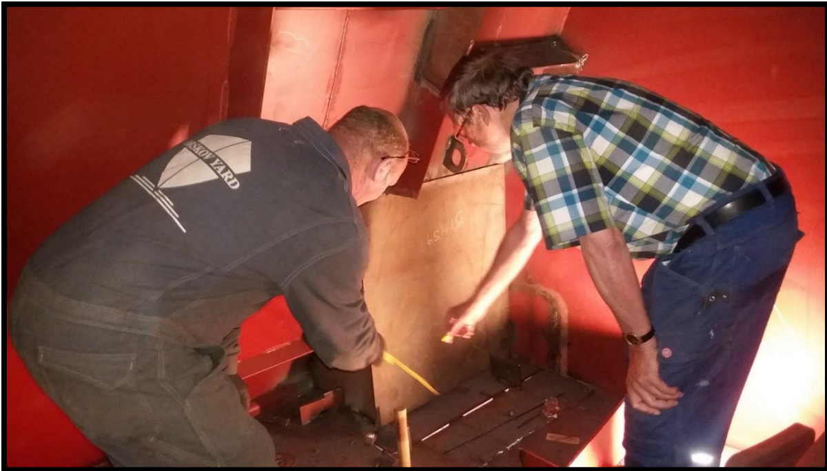
Smed og ingeniør besigtiger forstærkningen indefra.
