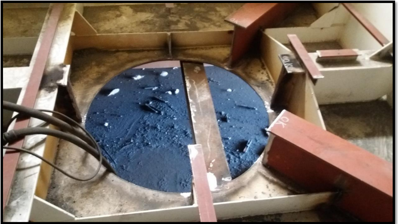
Hul og forstærkning til forankringen
