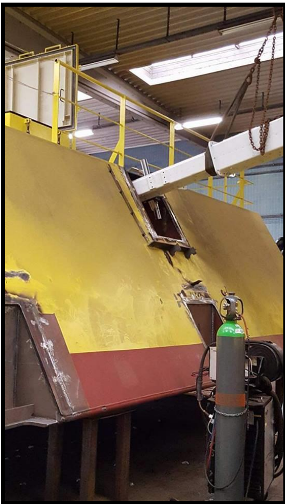
Lineærgear på vej ind i anlægget
