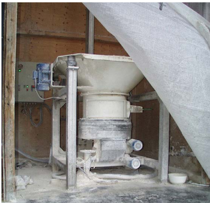
Figur 1: Kalkdoseringsanlæg.
