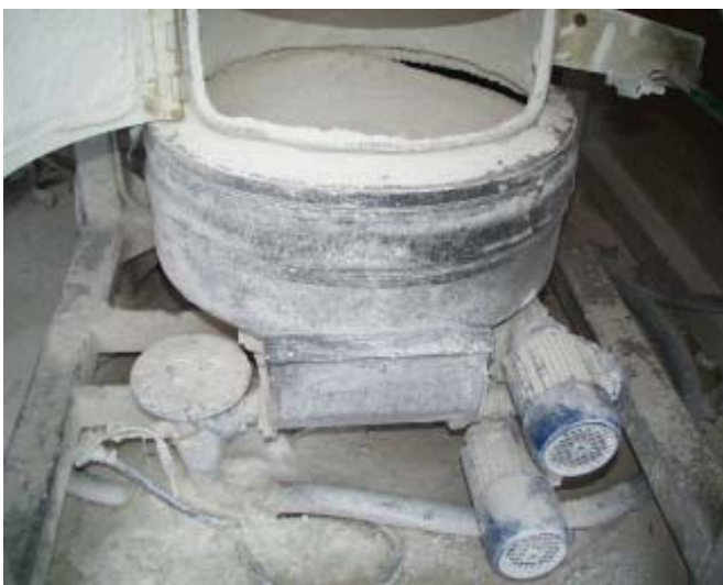
Figur 5: Omrører i bunden af siloen efter ombygning set gennem inspektionslugen.
