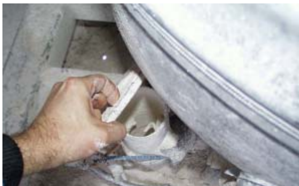
Figur 6: Ejektorens faldrør inspiceret ved at løfte den påsatte plade.
