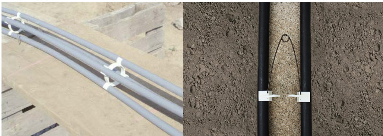
Figur 7.2: Eksempler på spacers der klikkes på rørene før sonden sænkes ned i borehullet.
