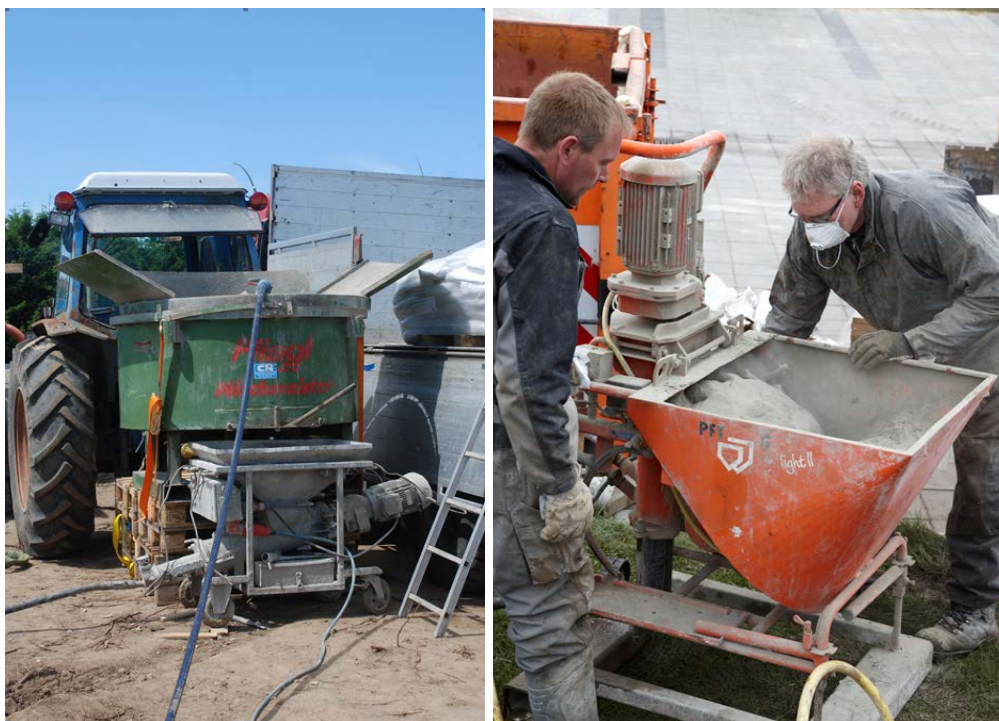
Figur 7.6 Batchblanding (til venstre) og direkte blanding af grout. (til højre). Til venstre ses blandekar der kan tømme ned i en snekkepumpe som efterfølgende pumper blandingen ned i boringen. Til højre ses blandemaskine hvorfra blandingen løbende kan pumpes til boringen.
