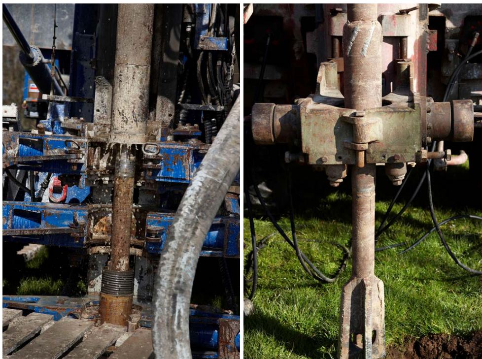
Figur 7.4: Skylleboring hhv. med og uden forerør.
