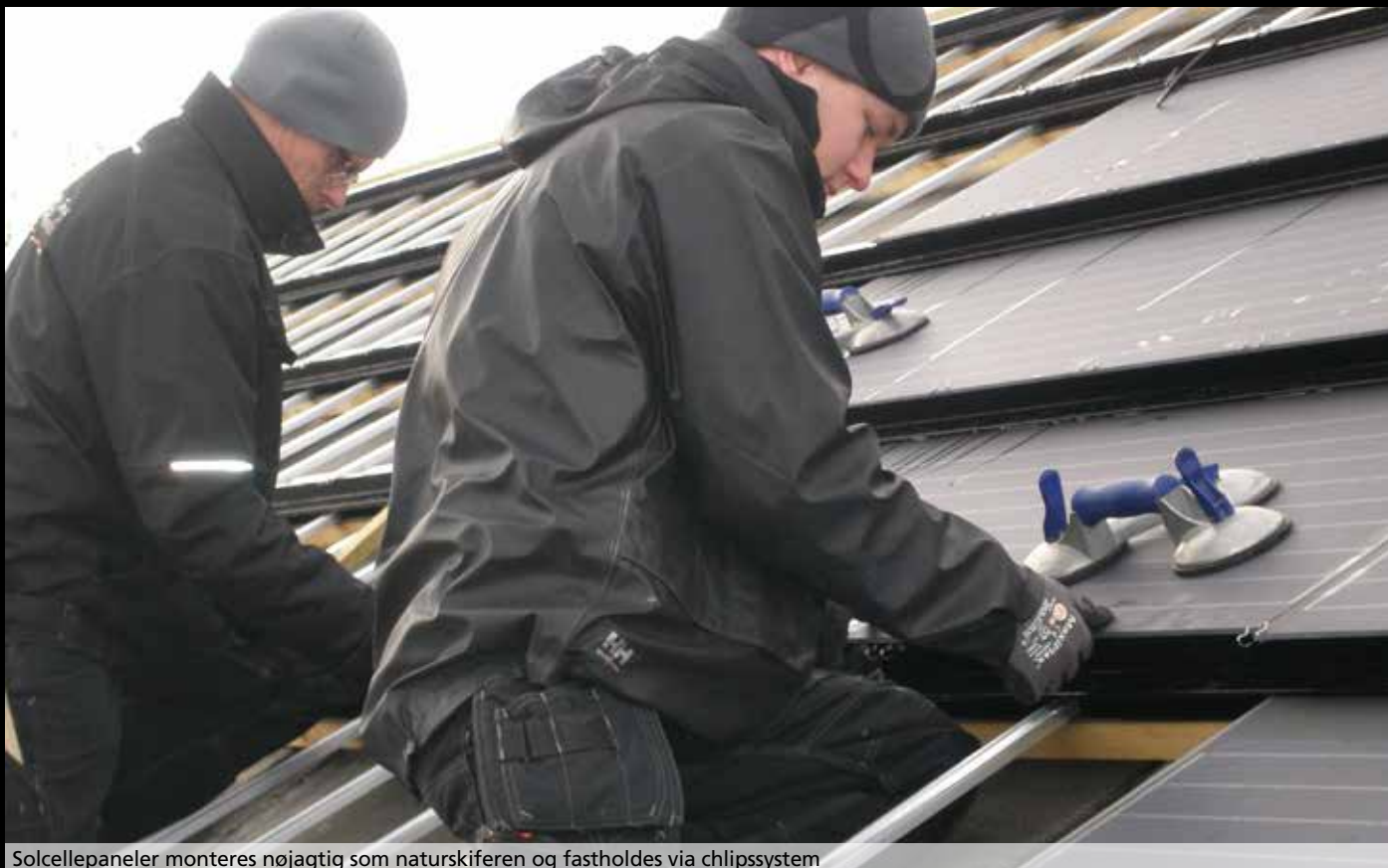
Alulægter monteres ovenpå almindelige trælægter med lægteafstand til naturskifer
