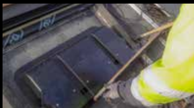
2. Element med boligventilation monteres
