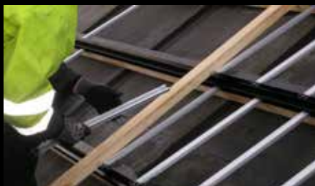
Forbindelseskanaler i aluminium monteres på lægtesystem
