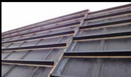
Alulægter monteres ovenpå almindelige trælægter med lægteafstand til naturskifer
