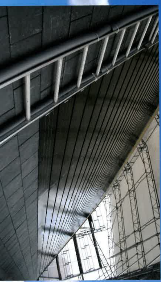
Danmarks største solcelleanlæg på en kirke i København integreret i KOMPROMENT Naturskifer, Barcelona Plain.
