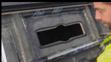
1. Etablering af hul for boligventilation i undertaget
