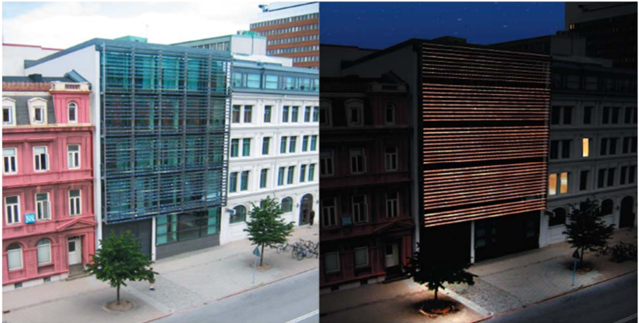
Figur 2 Forslag til solcellemoduler bygget som solskodder med indbyggede lysdioder
