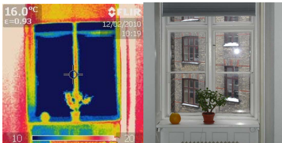
Figur 52: Det ikke-renoverede vindue mod gården i midterværelset i den tilsvarende lejlighed på 2. sal.
