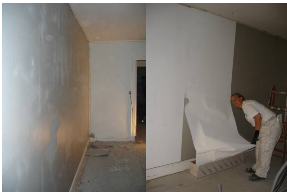
Figur 11: Efter montering af isolering blev væggen fuldspartlet og filtet inden afsluttende overfladefinish med maling.
