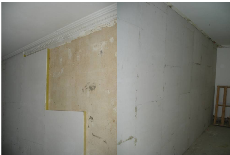
Figur 10: Montering af Aerorock på væg i prøvelejligheden - under og efter.
