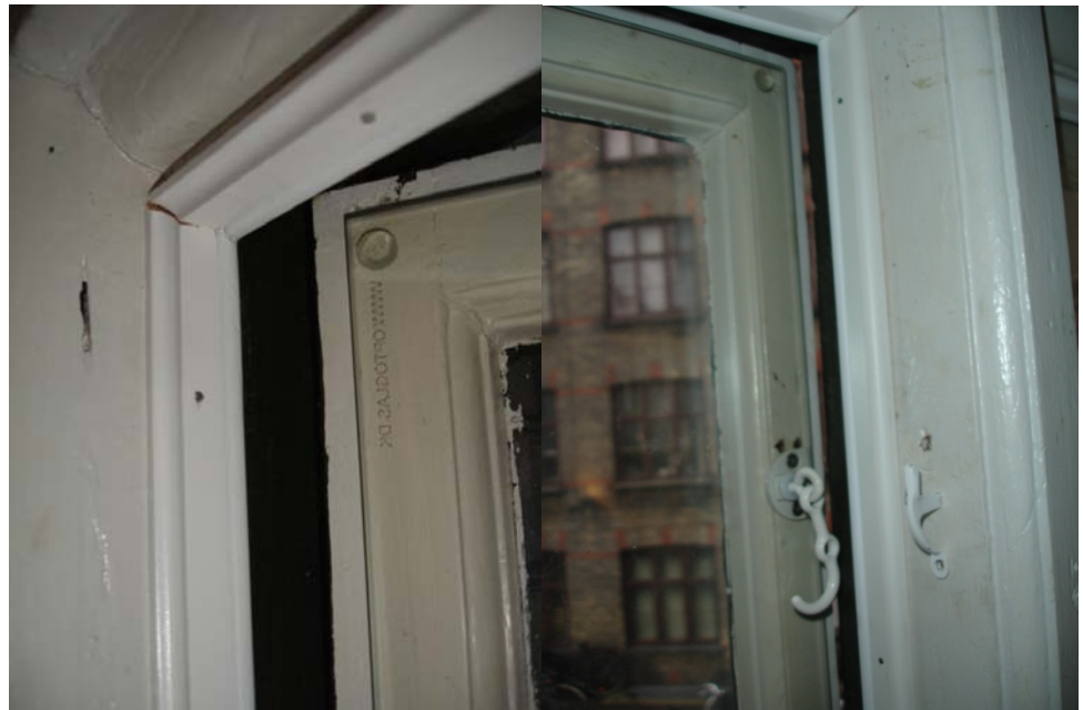
Figur 41: Renoveringsløsningen med Optoglas.
