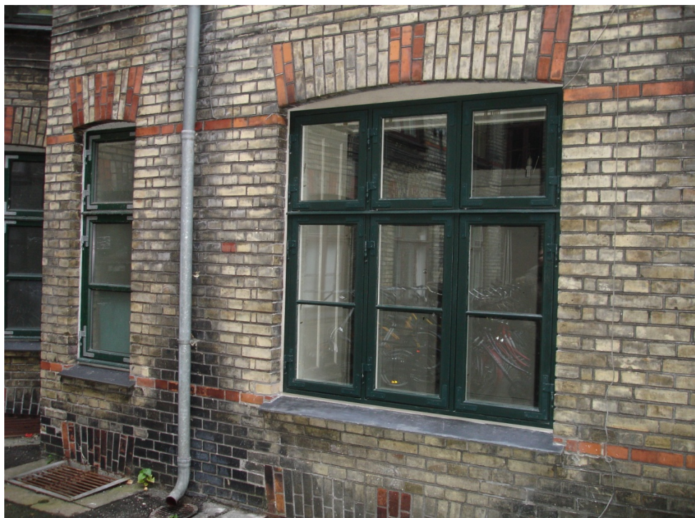
Figur 45: Nyt 3-fags dannebrogsvindue i gammel stil med 1+1 koblede rammer.
