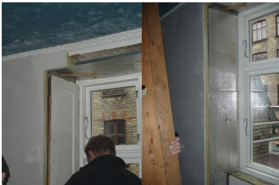
Figur 14: Montering af vakuumisolering i lysninger
