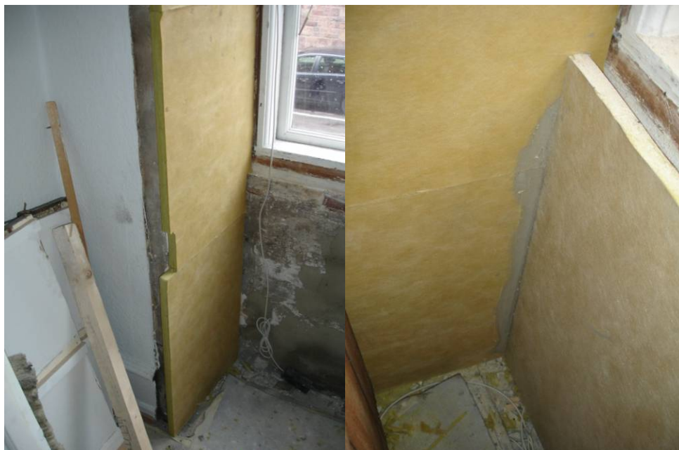
Figur 12: Montering af Aerowolle i venstre vindue mod gaden.
