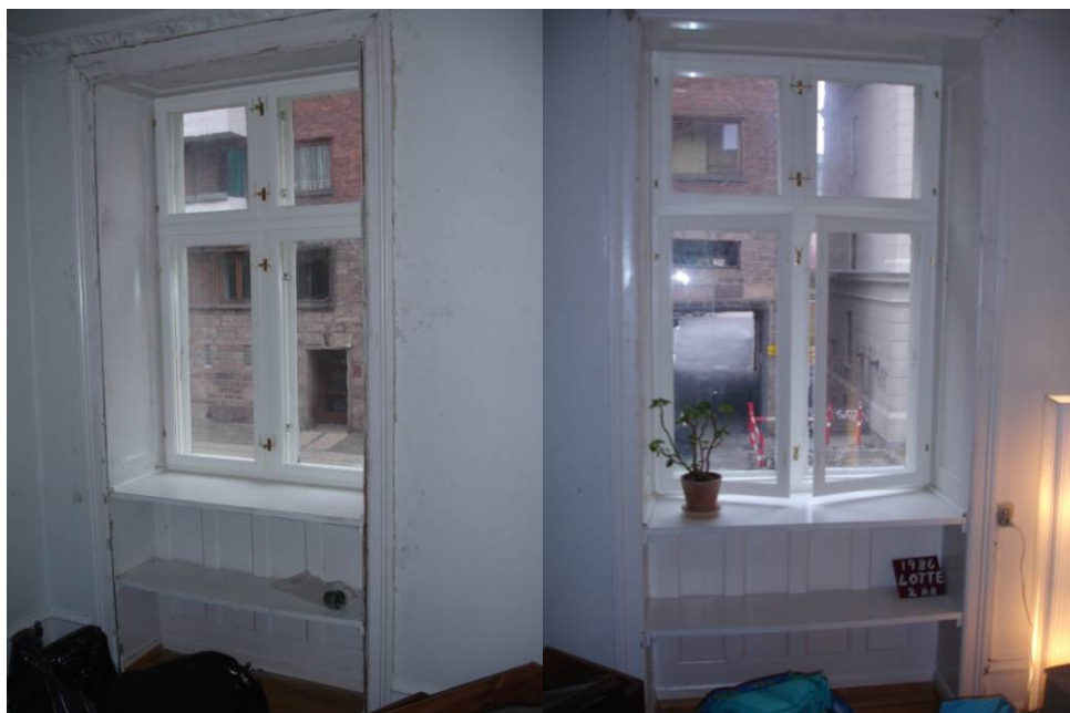
Figur 13: De færdige vinduer mod gaden mod hhv. til venstre og højre.
