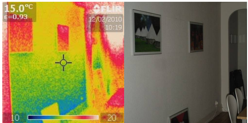
Figur 30: Uisoleret væg i midterste værelse i den tilsvarende lejlighed på 2. sal.
