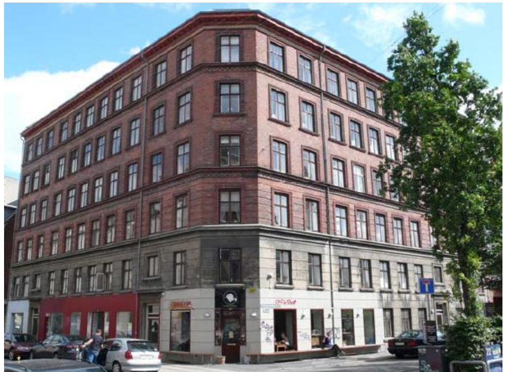
Figur 2: Ryesgade 30 før renoveringen.
