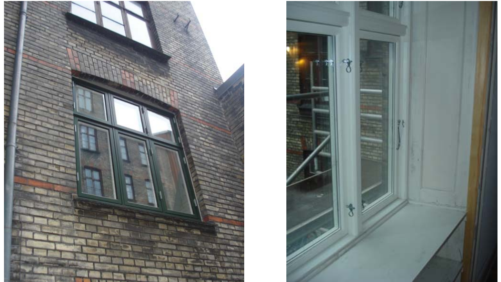
Figur 42. Nyt 3-fags dannebrogvindue med 1+2 koblede ruder, dvs. med 2-lags energirude i de koblede rammer
