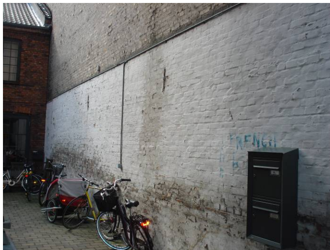
Figur 17: Målepunkter på overflade af eksisterende mur før indvendig efterisolering (øverste). Der er også målt i de to gulvbjælker umiddelbart under vægmålepunkterne (boret ind i bjælkeenderne). Billedet nederst viser det eksisterende murværk udefra, hvor det ses at murværket er i dårlig stand.
