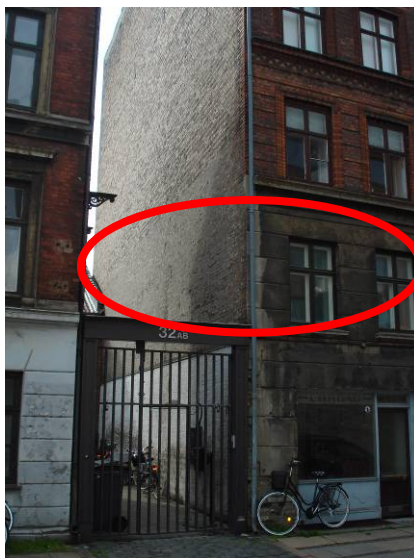
Figur 25. Prøvelejligheden Ryesgade 30 C, 1 tv, er beliggende til højre lige over porten, og det er i gavlen at der er udført målinger på bjælkeenderne.
