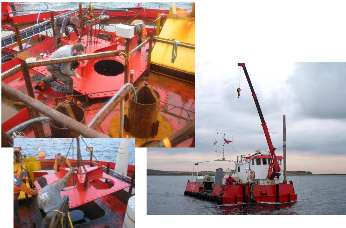
Figur 8.3 Montage af turbine på havet, september 2003.
