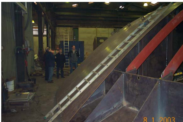
Midterdel af rampe under opsvejsning.
