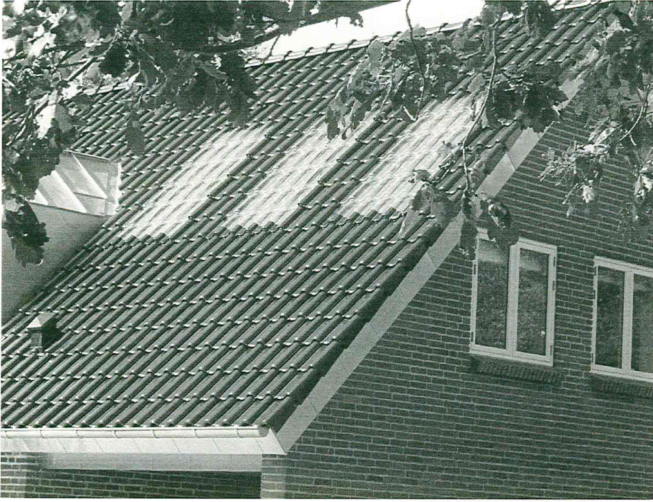
Hus i Ølgod monteret august 2011
