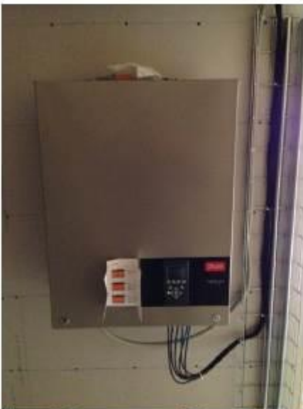
Figur 4 - Inverteren er af Typen Danfoss TLX Pro 12,5 kW
