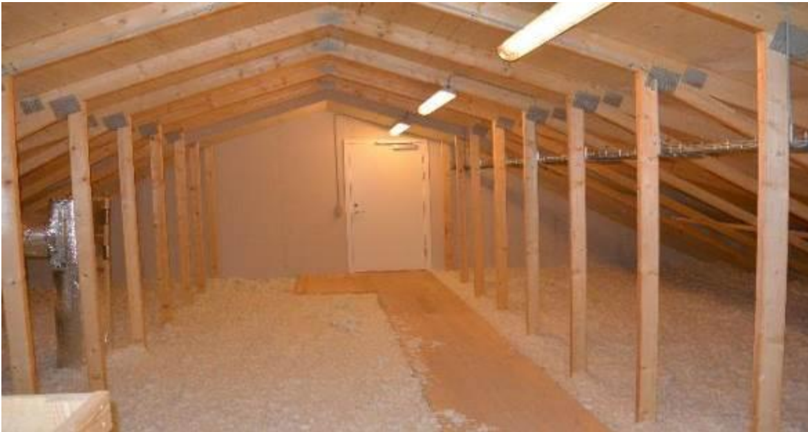
Fig. 2. 13 Det nye loftsrums i Hornemanns Vænge er isoleret med papirgranulat, der skaber en god lufttæthed.
