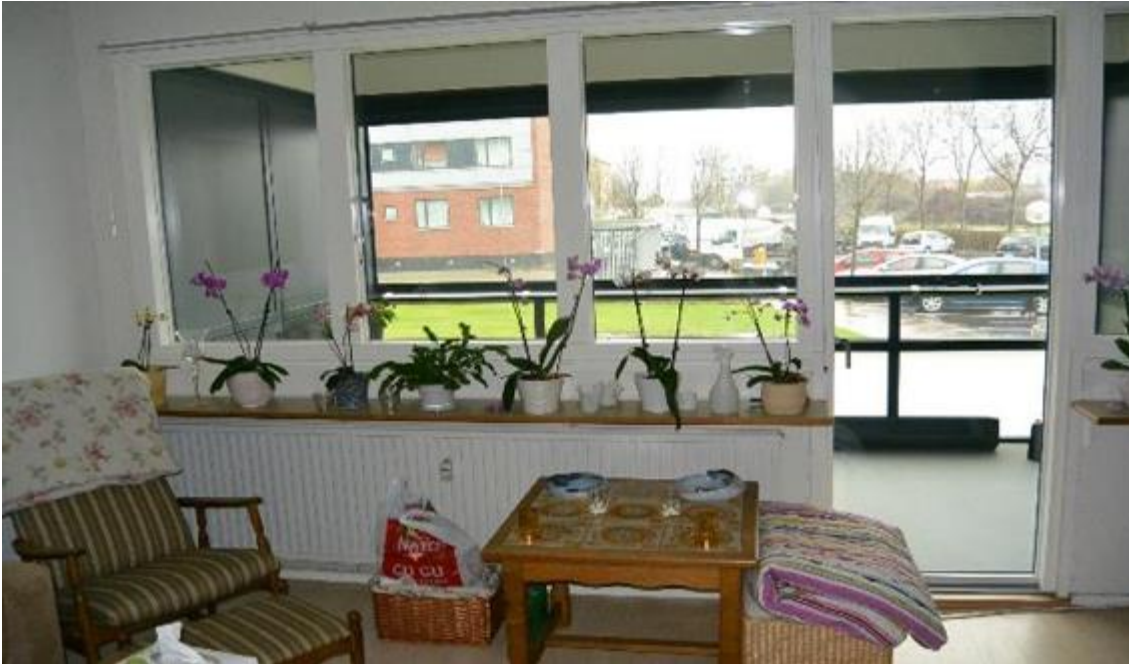
Fig. 2. 10 Det meste af den glasbelagte facade kan foldes sammen, for at undgå overophedning om sommeren.
