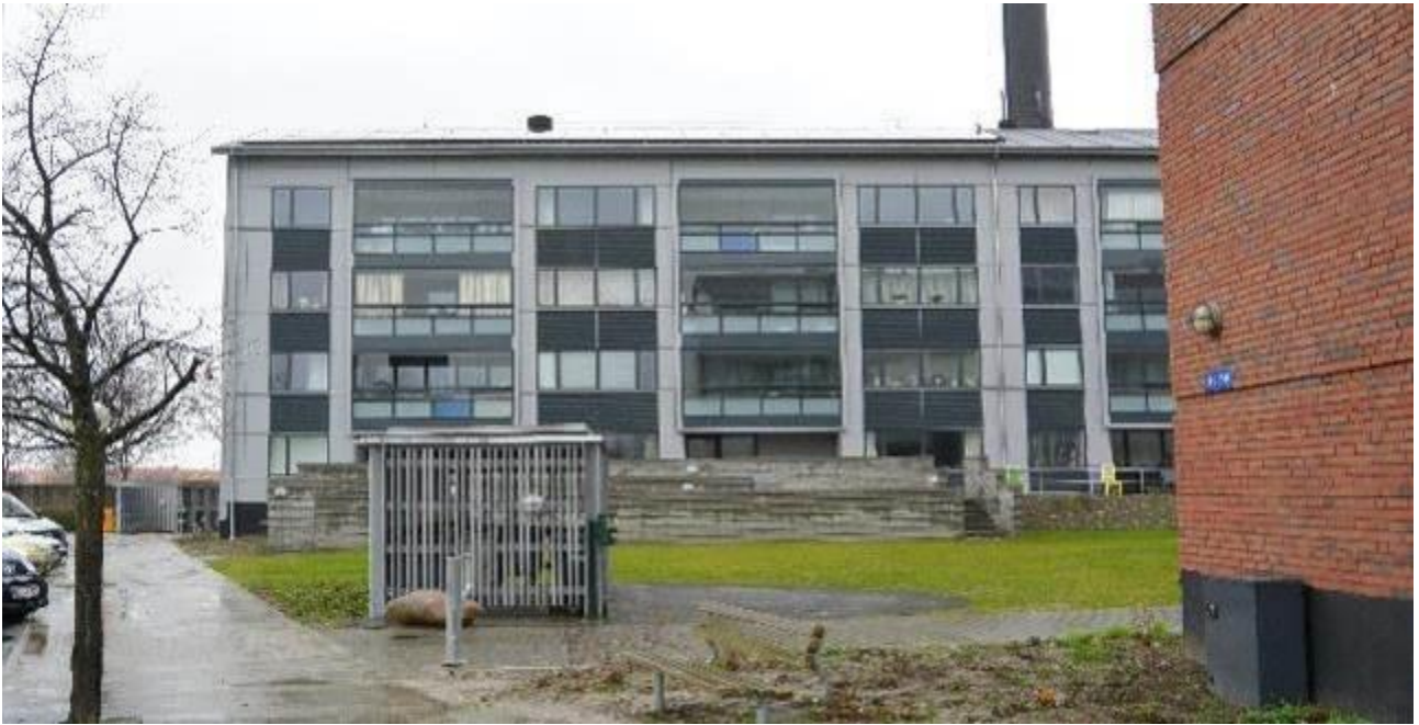
Fig. 2. 8 Den gamle betonbebyggelse er blevet renoveret fuldstændigt med nye facader og glasinddækning af altanerne. Både solceller og solvarmeanlæg er integreret i den ny skrånende tagkonstruktion.
