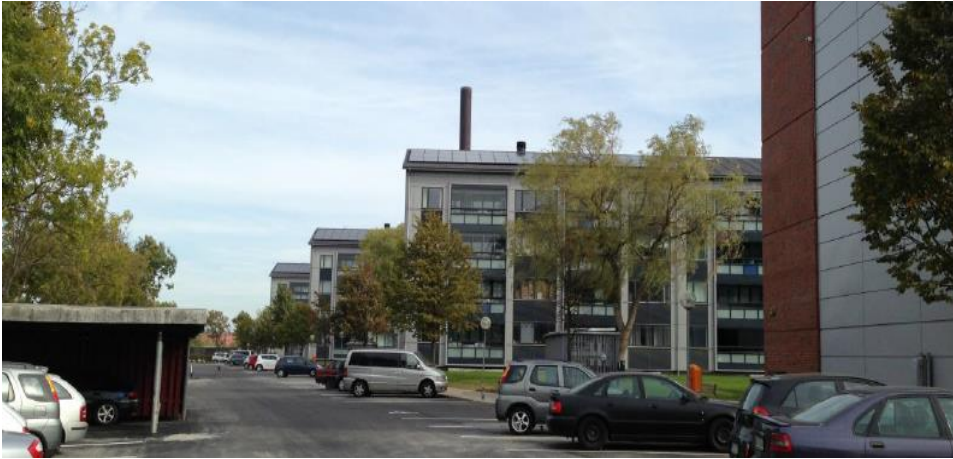
Fig. 2. 2 Hornemanns vænge i Valby er et stort betonrenoveringsprojekt med 288 lejligheder
