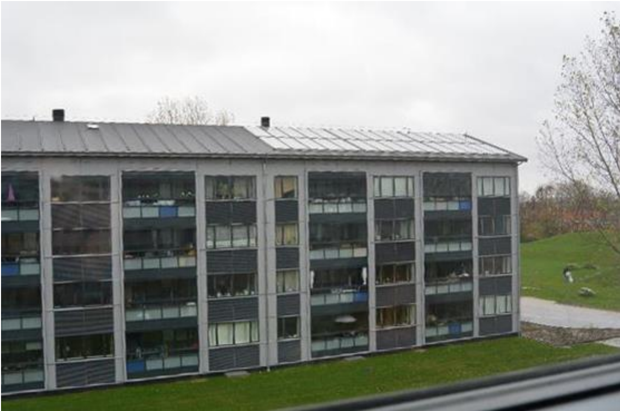
Fig. 2. 12 100 m 2 solvarmeanlæg pr. boligblok anvendes til det varme brugsvand. Der var tale om en relativ høj udgift på ca. 6.000 kr. pr. m 2 .
