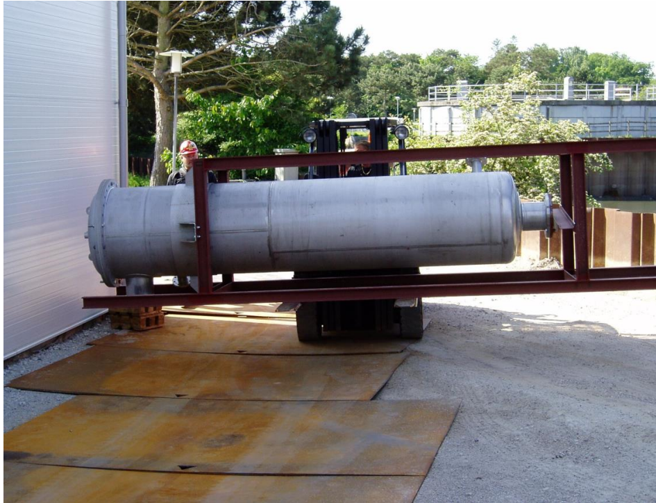
Figur16: Kondenserende røggaskøler konstrueret af BioSynergi Proces på vej til installation i maskinhallen.
