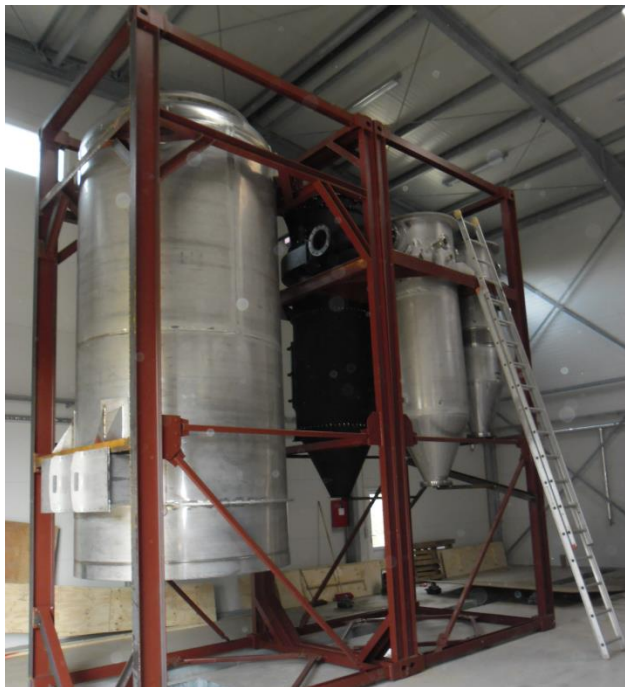
Figur 13: Montage af gasgenerator og gasrensingsmodul.
