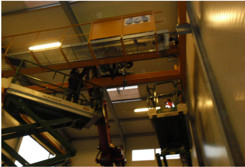
Figur 7: Montage af det fuldautomatiske krananlæg
