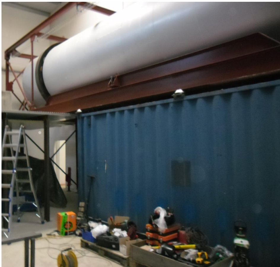
Figur 11: Montage af tørreanlæg i maskinhal.
