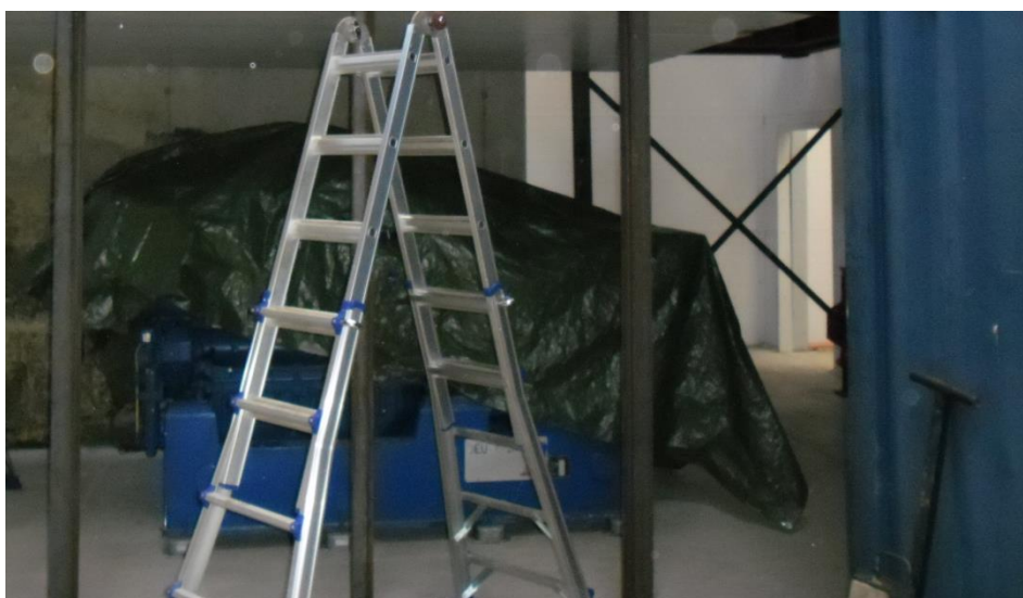
Figur 14: Gasmotoranlægget ankommet til installation i maskinhallen.
