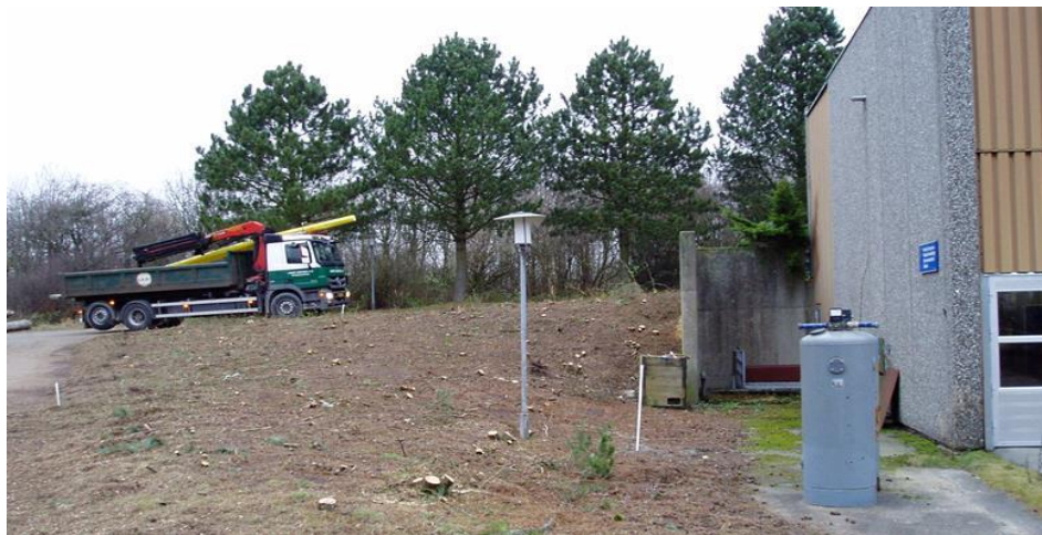
Figur 3: Starten på arealrydning og afsætning af bygning
