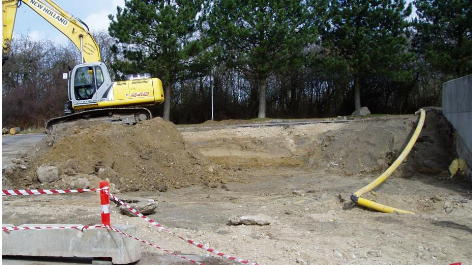
Figur 4: Omlægning af gasrør og arealrydning
