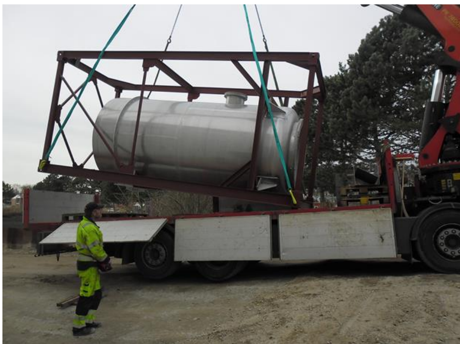
Figur 12: Gasgeneratorens grundmodul aflæsses udenfor anlægsbygningen.
