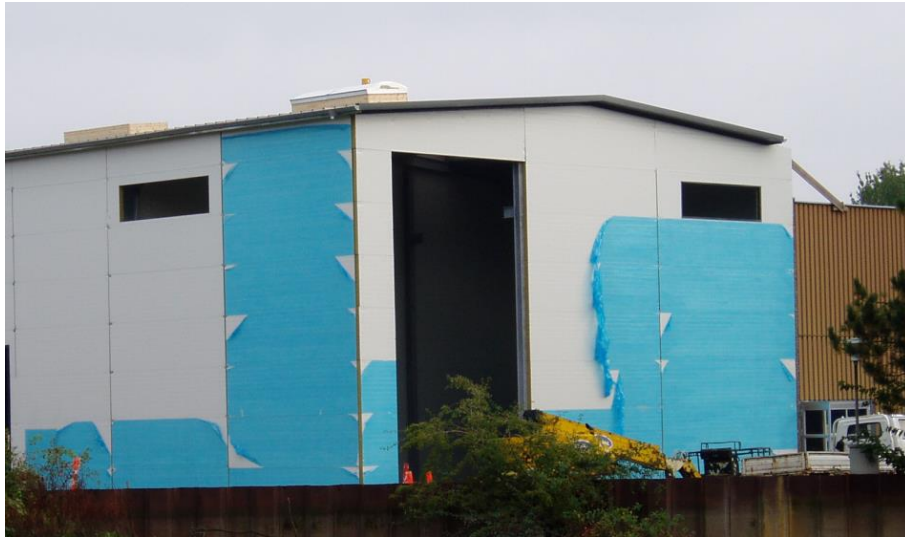
Figur 6: Næsten færdig bygning i 3 kvartal 2012
