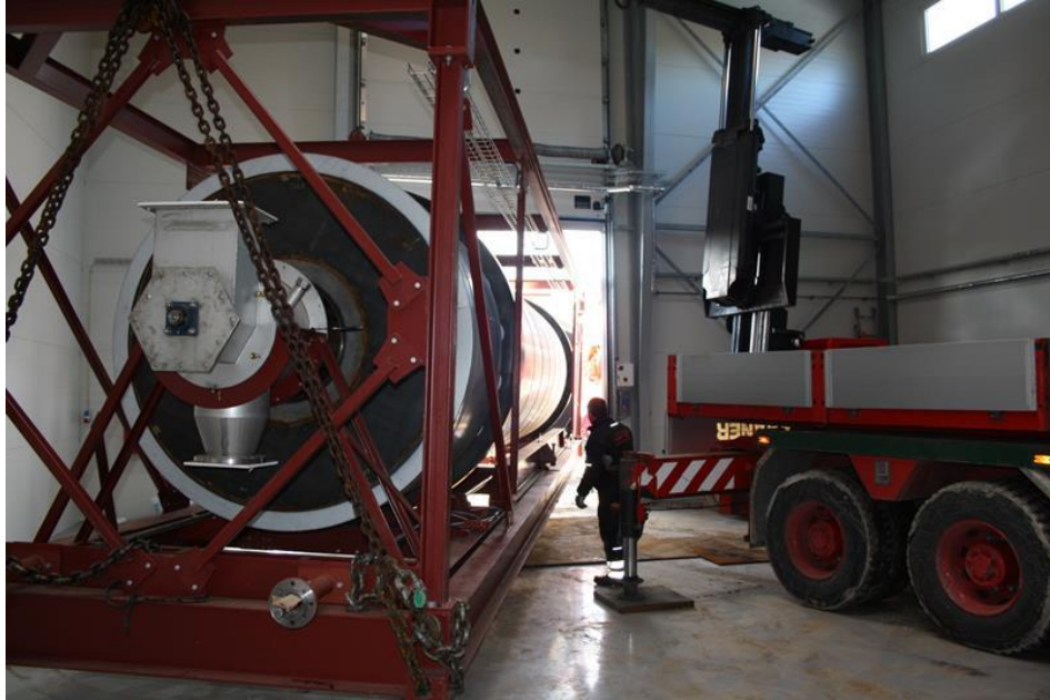
Figur 10: Tørreanlægget lempes ind i maskinhallen.
