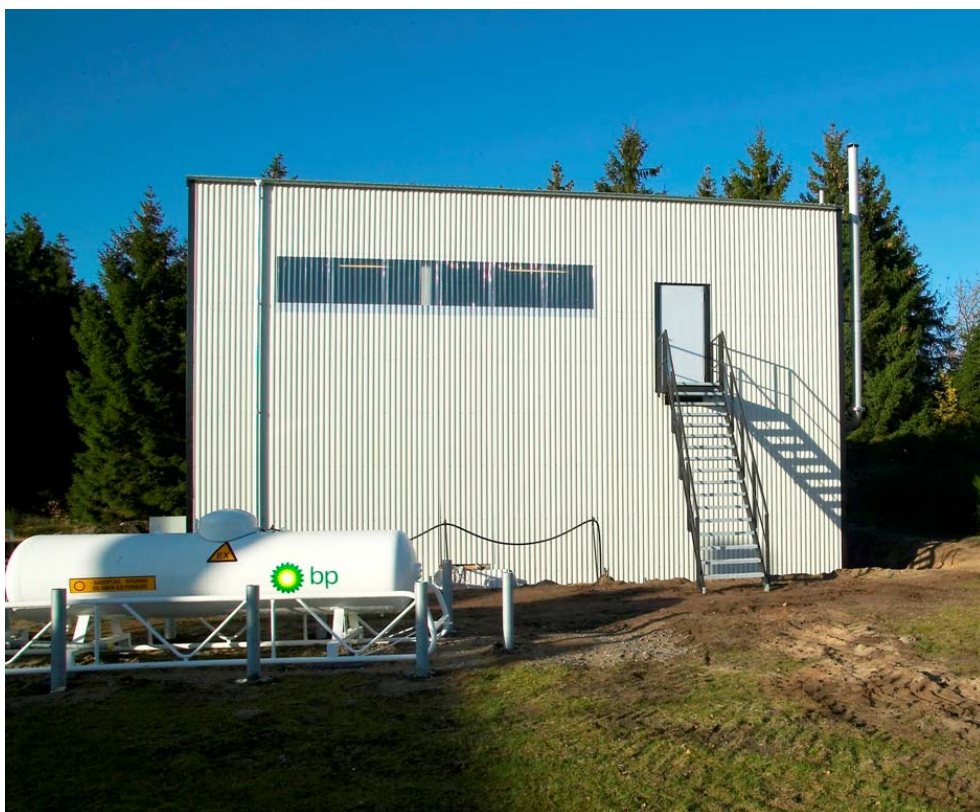
Figur 3.5 Bygning til pilotanlæg og LFG anlæg til opstart af anlæg.
