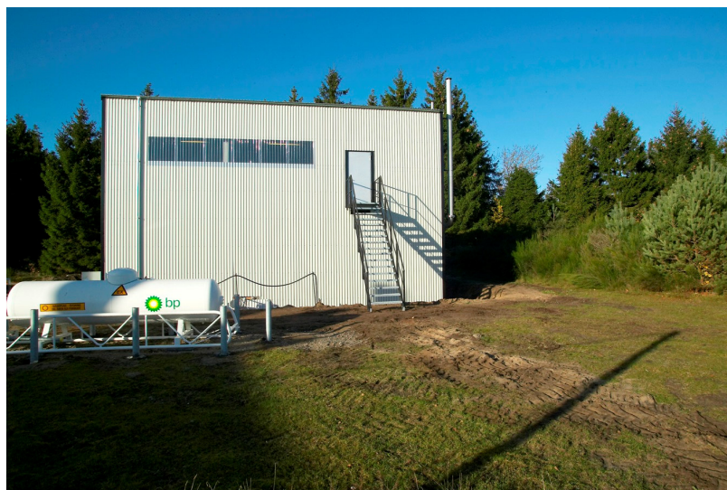
Figur 8.8 Bygning til pilotanlæg.
