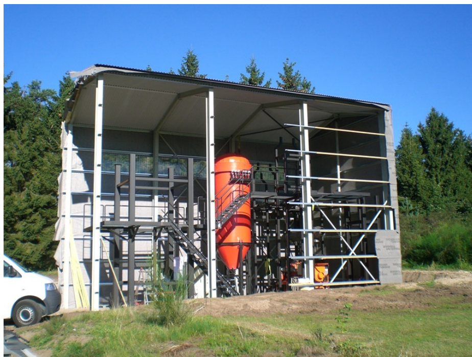
Figur 8.3 Bygning til pilotanlæg. Posefilter og motor er sat ind.
