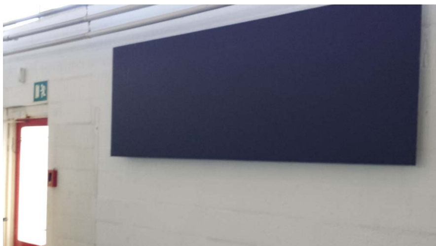
Solcellemodul med 8mm glas ophængt vha. omega profil beslagsystem
