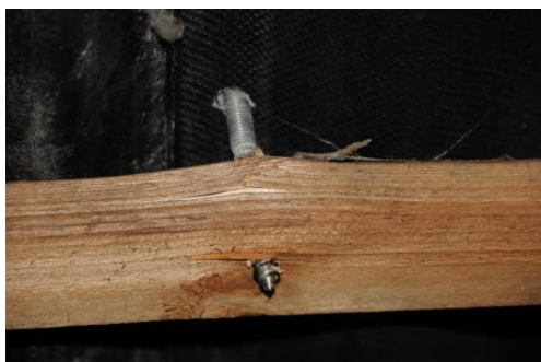
6 - Ansatsskrue sidder yderligt og er for lang
