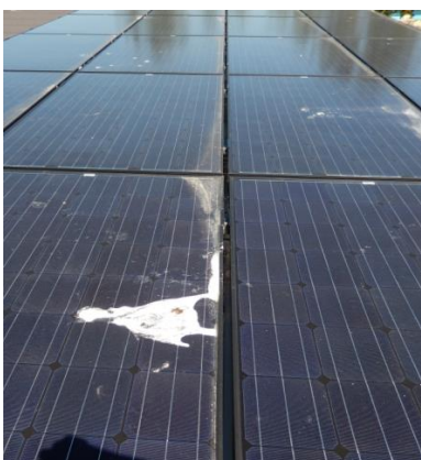
11 - Flade moduler med mågeklatter, der er så store at det kan ses på målinger af elektrisk ydelse. Rammes solarimeteret, måler det forkert! (Nexø Skole)
