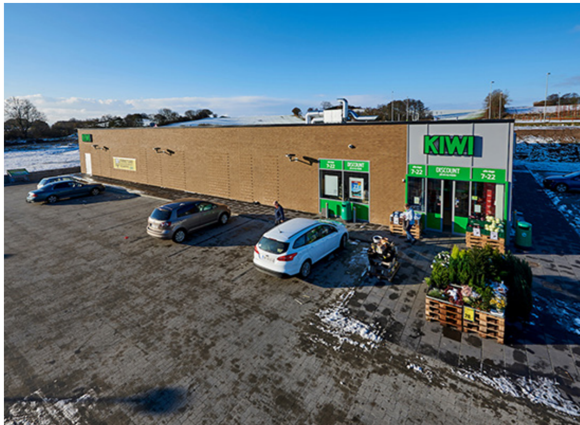
KIWI Malling - østlige facade mod Krekærlundsvej
