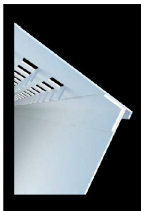
Trin 4: aluminiumsplade samles med nitter ved vinkelprofil
