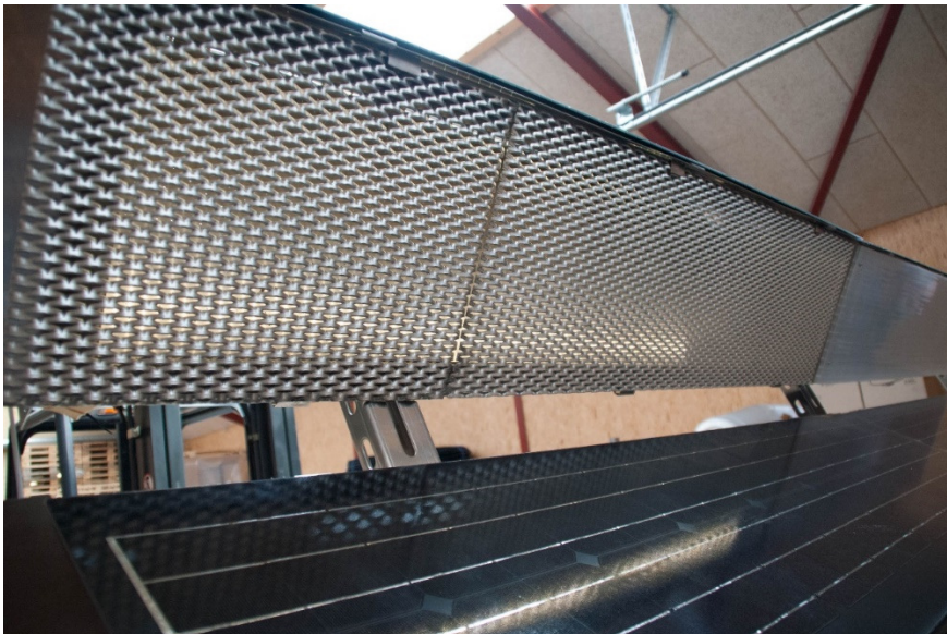
Figur 39 Inddækningsplader af strækmetal, belyst bagfra
