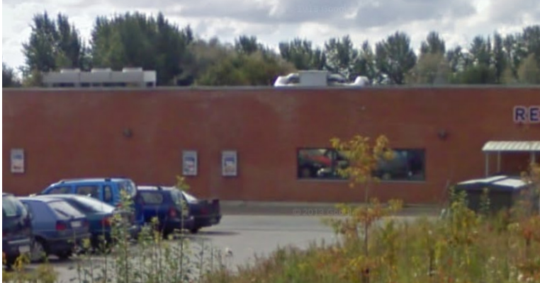
Figur 11 Tørkøler med 3 ventilatorer til venstre i billedet
