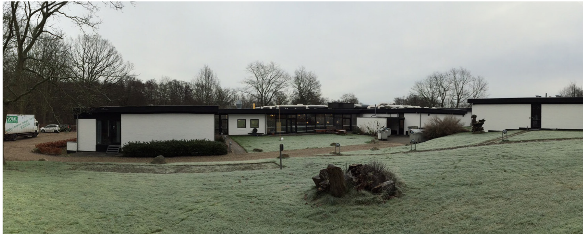
Kig fra bygningens vestside, hvor de eksisterende installationer tydeligt ses –især pga. terrænet som stiger fra øst mod vest.
