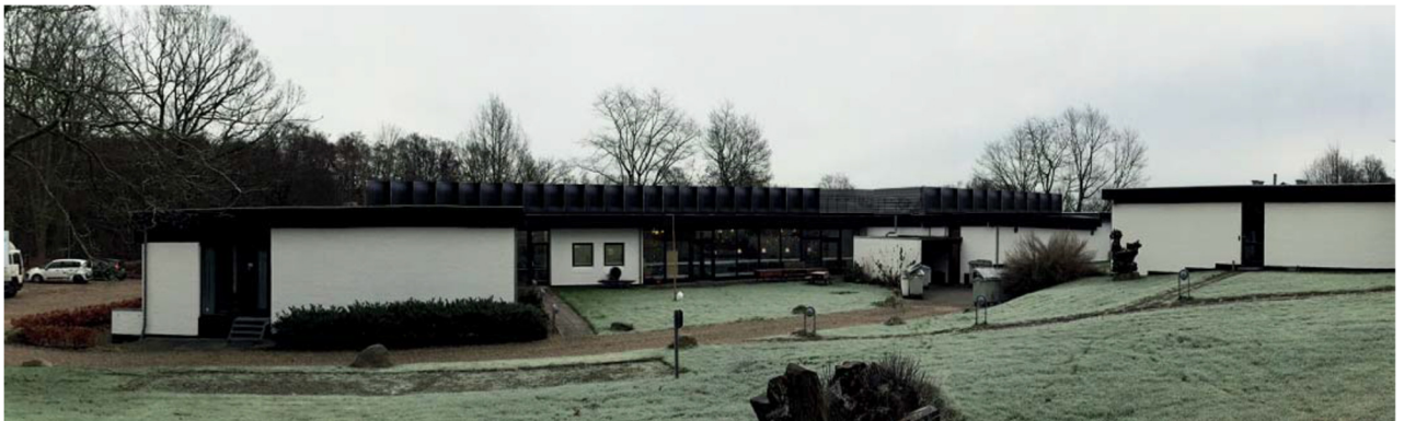
Figur 48 Arkitektonisk taginddækning udført med almindelige solpaneler
