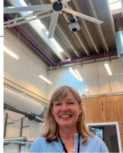
Oppe under loftet på en forsøgshal på Teknologisk Institut drejer fem vinger langsomt og lydløst rundt over hovedet på projektleder Merete Lyngbye. Nydesignede vinger skaber luftcirkulation og et mere behageligt indeklima.
