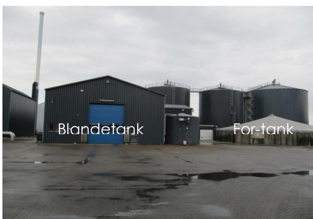
Billede: Blandetank og for-tank ved Thorsø biogas.
