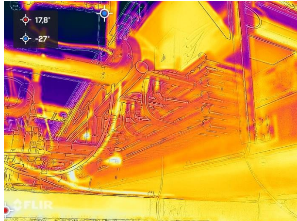
Foto og termografisk billede af fordamperheadere
