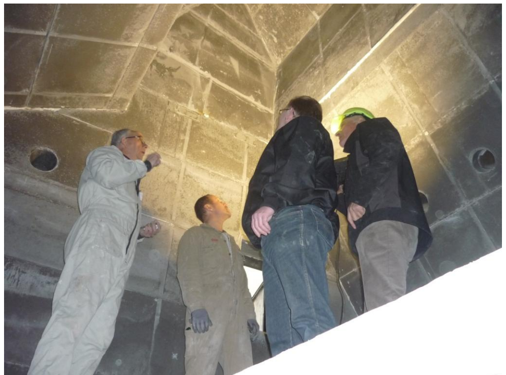
Figur 3.5 Inspektion af udmuring. Februar 2011.
