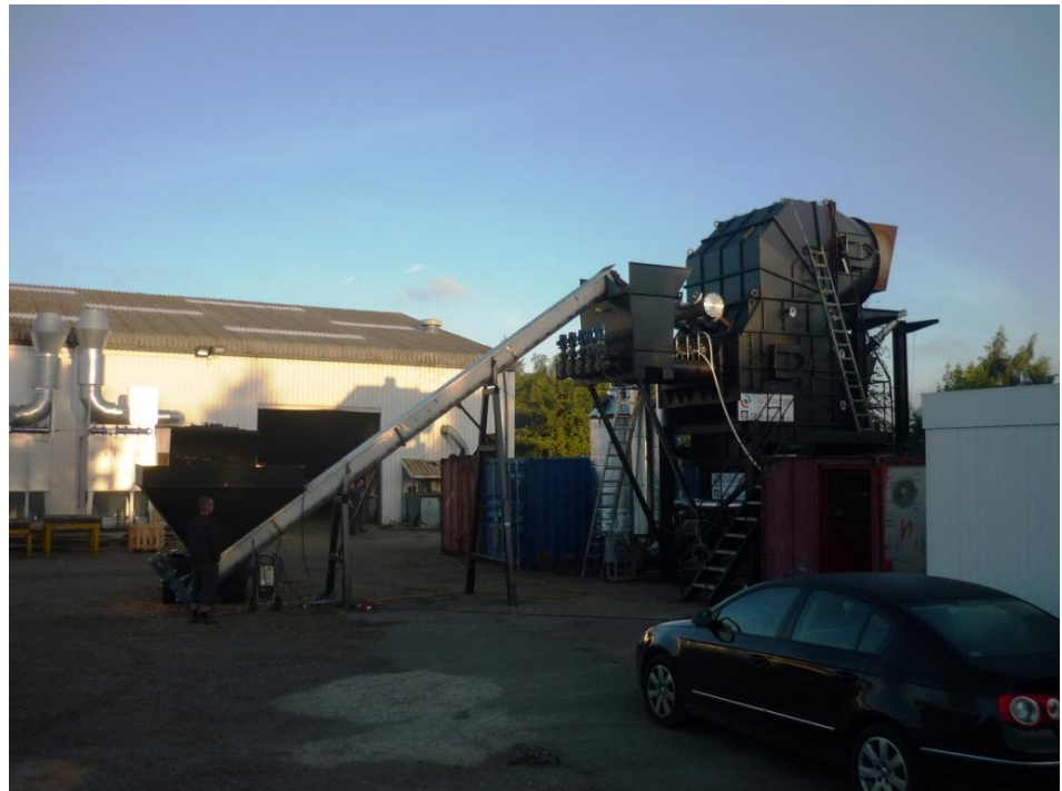
Figur 2.3 Pilotanlægget om morgenen under test i uge 35, 2010.
