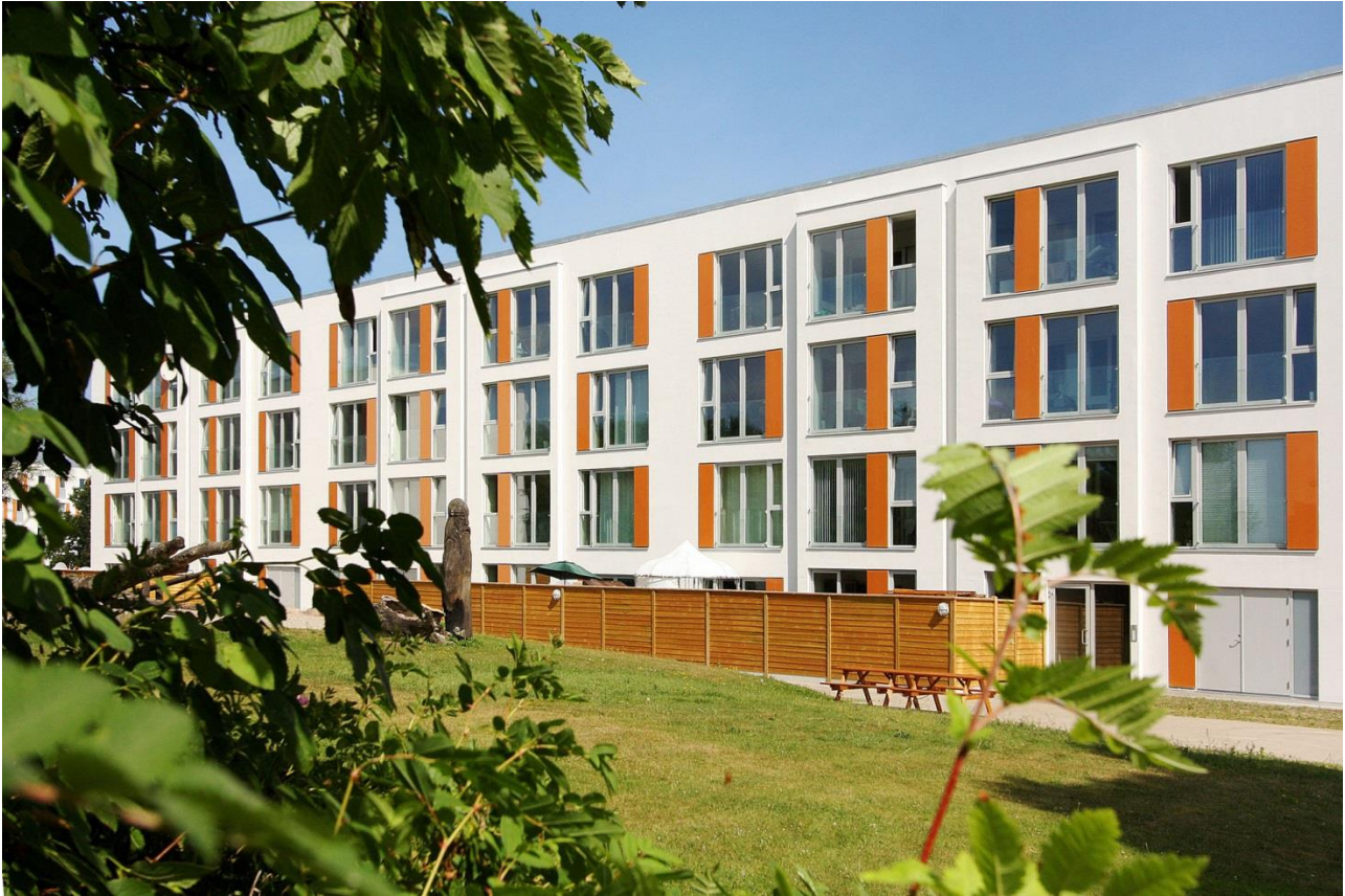
Figur 39 Nye facader på Heimdalsvej.
