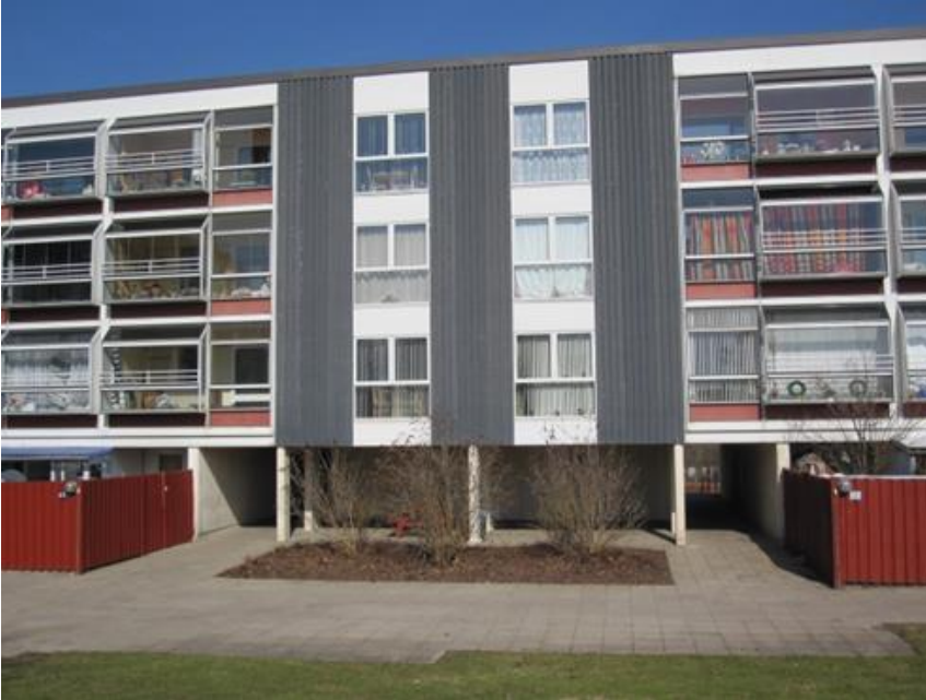
Figur 58 Foto af boligblokken på Heimdalsvej før renovering.
