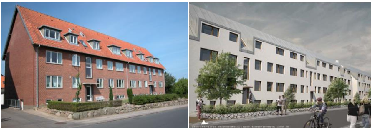
Figur 2. Foto af muret etageboligbyggeri fra sidst i 1940'erne (tv). Til højre ses en visualisering af, hvordan etageboligblokken kan opnå et anderledes og moderne arkitektonisk udtryk ved en gennemgribende udvendig efterisolering. Visualisering af Creo Arkitekter.
