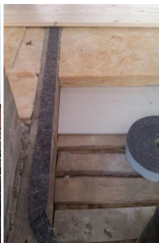
Figur 21. Efterisolering af etageadskillelsen
