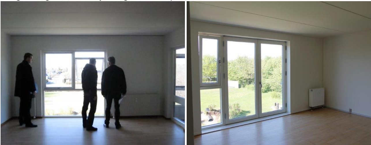
Figur 2. Eksisterende vinduer med gamle termoruder (t.v.) udskiftes med nye vinduer med 3-lags lavenergivinduer (t.h.). I stuen forøges vindues- og glasareal, således at lysindfaldet ikke reduceres men tværtimod øges.
