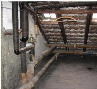
Fremføring af rør på loft.
