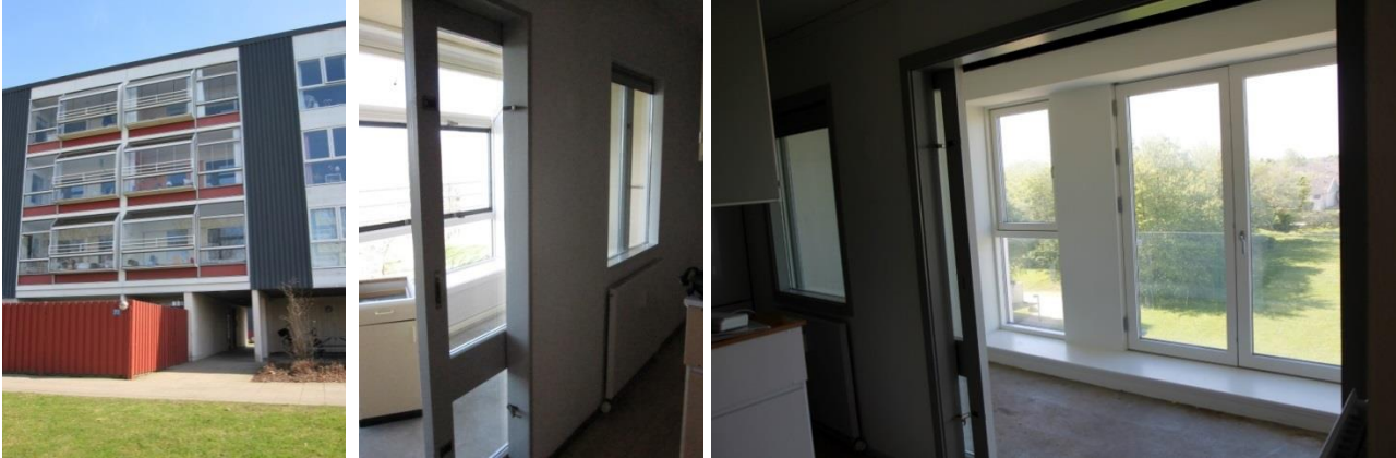
Figur 11. Inddækkede altaner med enkeltglas før energirenovering (tv og midt). Inddækkede altaner med 3-lags ruder efter energirenovering (th).
