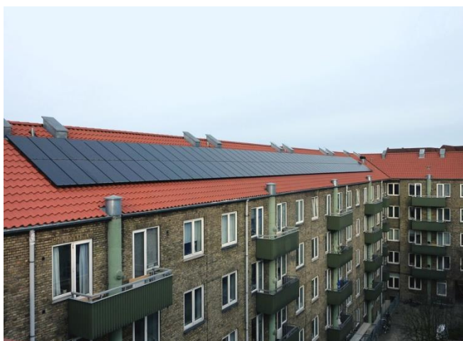
Figur 20. 490 m 2 solceller på tagfladerne
