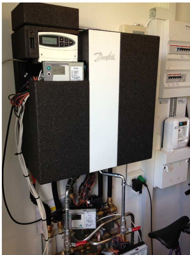
Figur 14 - Fjernvarmeunit fra Redan type LES fuldisoleret og med fremløbstemperaturstyring. Underliggende installationer ikke isoleret pga. igangværende demonstration med ekstra målere.
