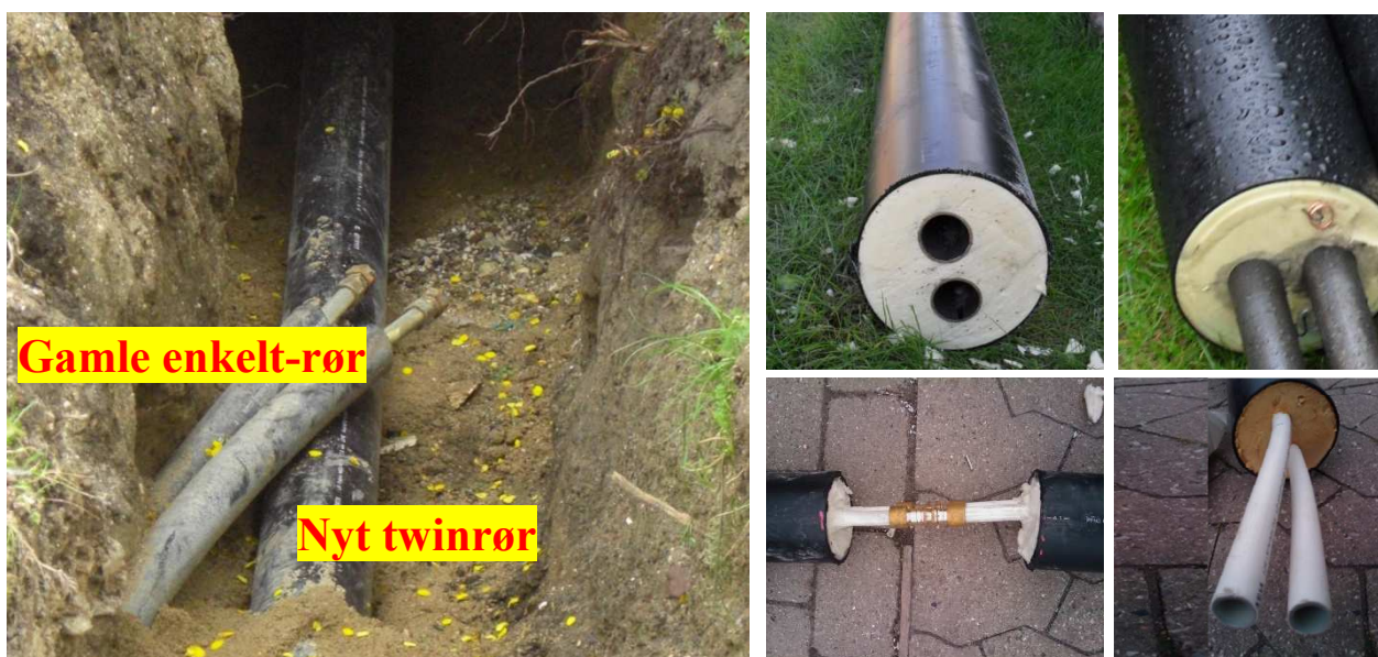
Figur 13: Eksempel på nyt twinrør med stor isoleringstykkelse, der erstatter de gamle enkeltrør med ringe isolering (til venstre). Eksempler på stål twinrør til gadeledninger (øverst til højre). Eksempel på alupex twinrør – et af billederne viser også en samling (med fittings), før der afsluttes med muffe og skumisulering (nederst til højre). Fjernvarmerørene har indbygget kobbertråde til lækage-alarmsystem.
