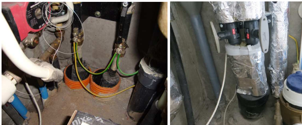
Figur 18: Eksempel på en stikindføring med to enkeltrør (til venstre), der nu er erstattet af ét twinrør (til højre). Bemærk, at billederne ikke stammer fra samme hus.
