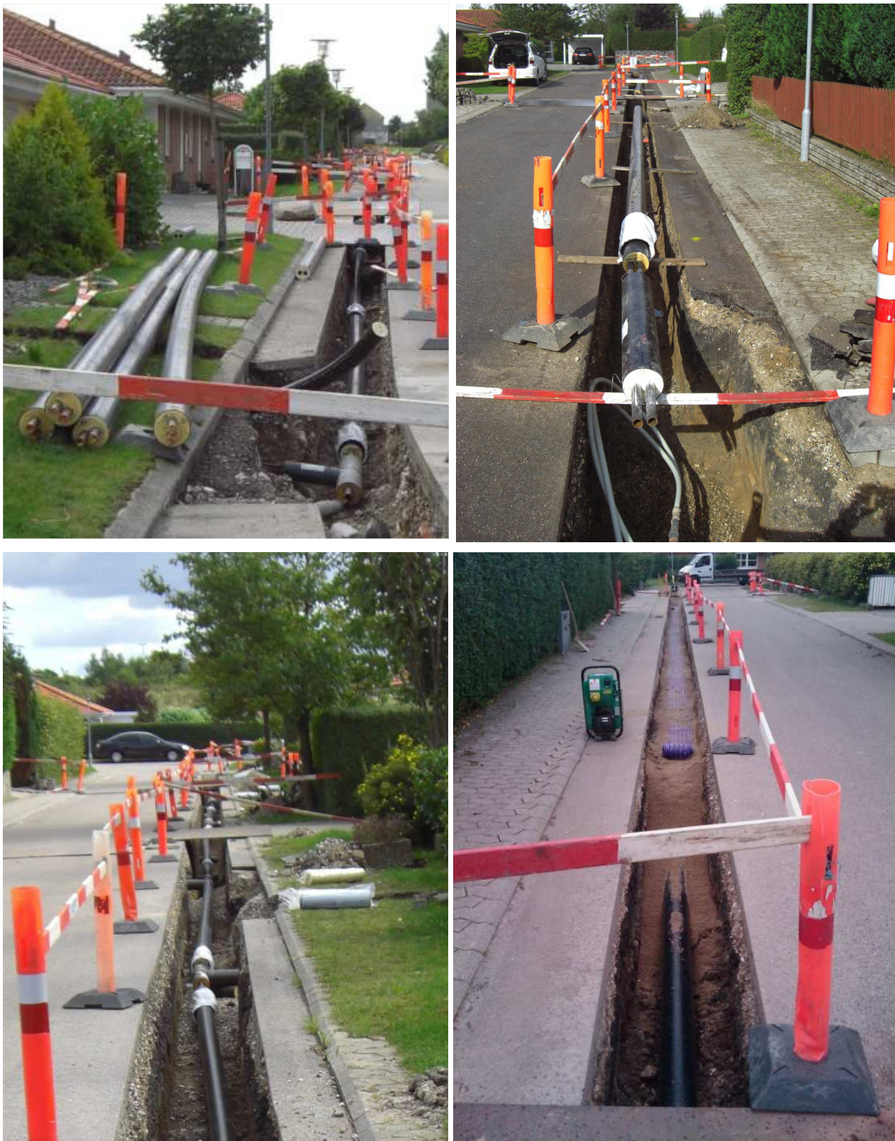
Figur 14: Billeder fra arbejdet med etablering af det nye fjernvarmenet. Entreprenørarbejdet pågik i sommeren 2011. Øverst ses stålør, hvor svejsearbejde stadig pågår. Nederst til venstre ligger rør klar til muffearbejde. Nederst til højre ses et færdigt trykprøvet stykke fjernvarmeledning, der er ved at blive tildækket og advarselsbånd er ved at blive udlagt.
