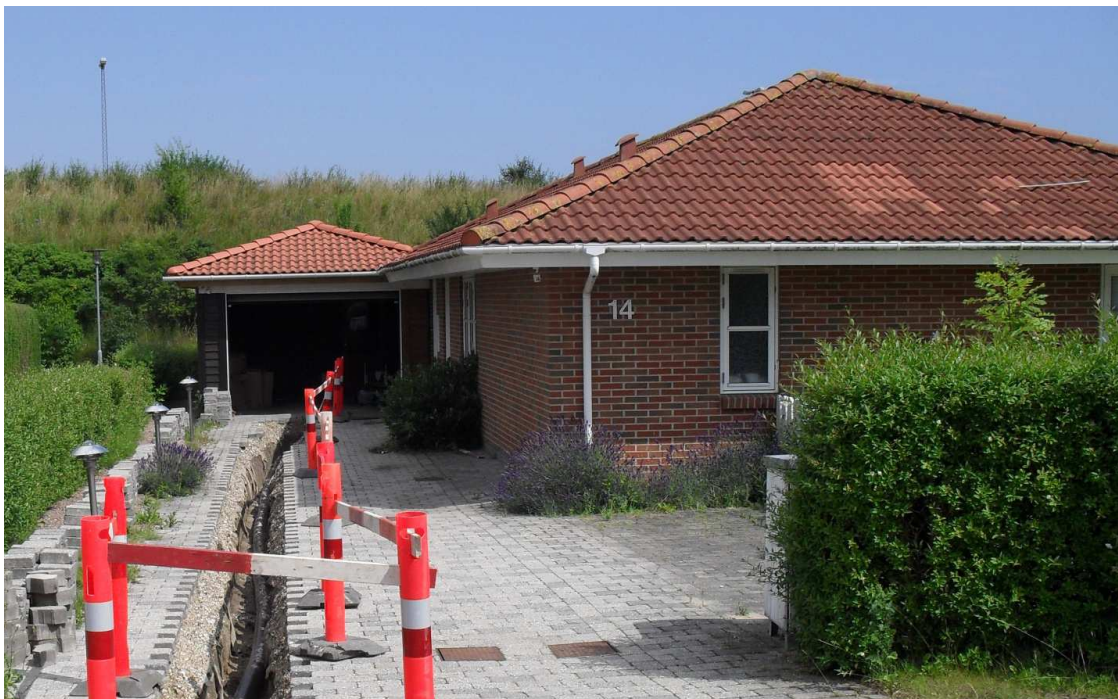
Figur 15: Eksempel på en ny stikledning, der er ført til et hus i Sønderby.
