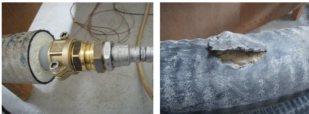
Figur 30: Test af et stykke ca. 15 år gammelt fjernvarmerør fra det eksisterende fjernvarmenet i Sønderby.
