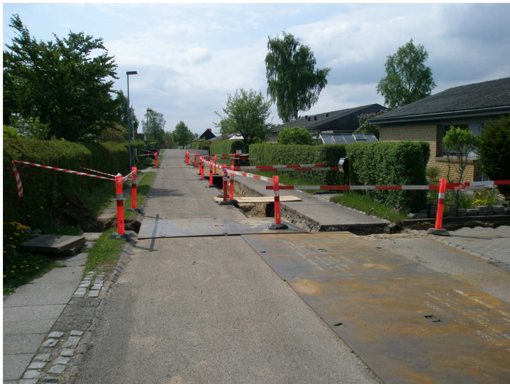
Figur 8 - Renovering af ledningsnet i Skjoldhøjeparken sommeren 2013
