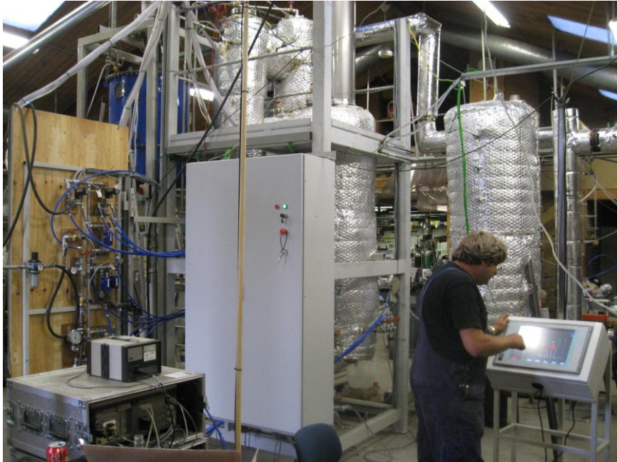
Figur 2: 100 kW LT-CFB forgasser på DTU, med påbygget PLC-skab, fritstående kontrolpanel til højre, set fra sydøst.
