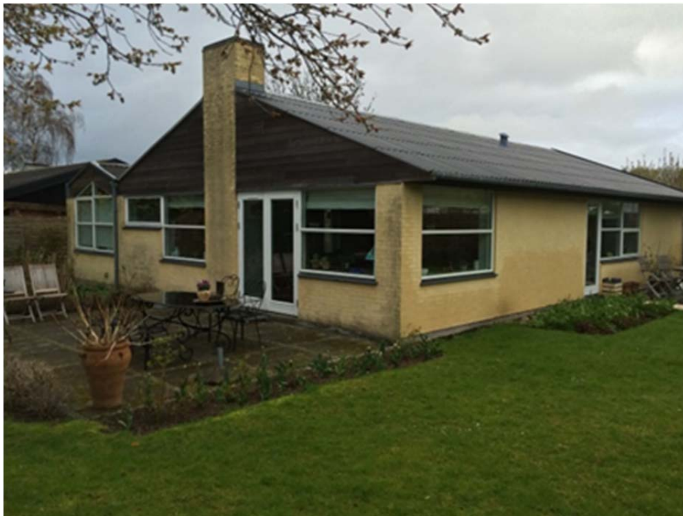
Figur 1 Foto af huset i Kokkedal, hvor det ene anlæg blev installeret
