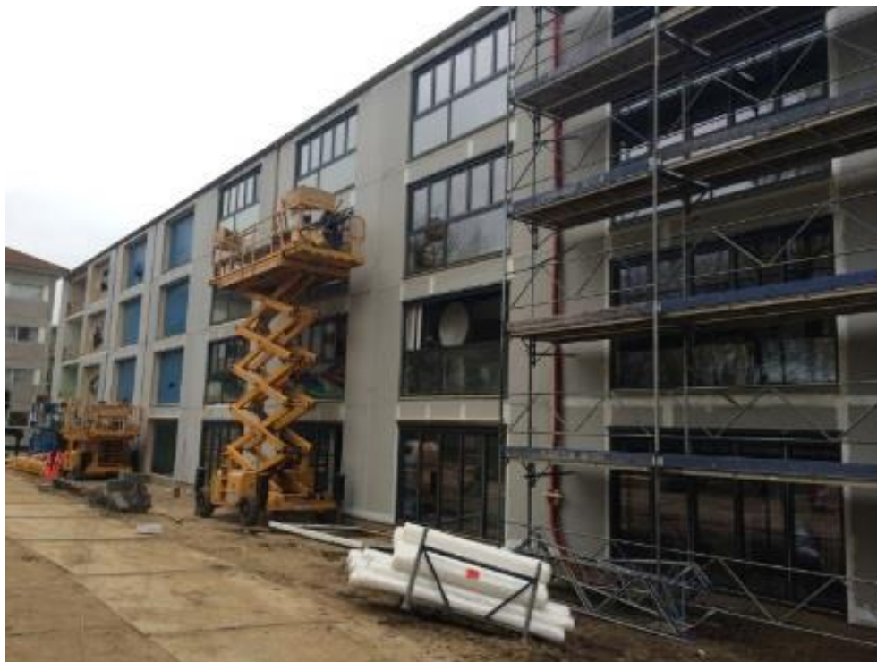
Figur 7: Altaner under byggeperioden, efter den nye glasfacade er monteret.
