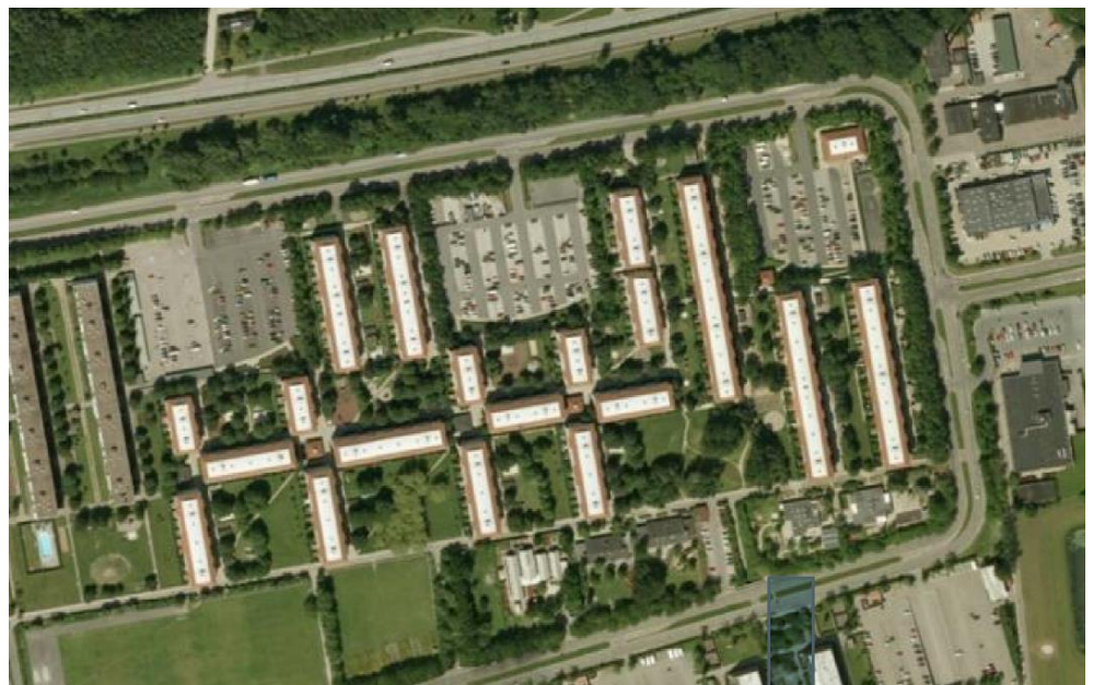
Figur 3: Luftfoto over Gadehavegård. Foto: ©COWI ©Geodata. DK-DDOland2010_125mm_UTM32ETRS89
