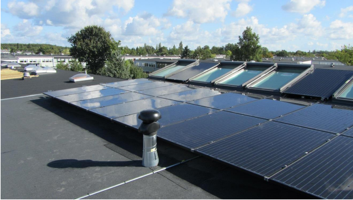
Endelig løsning for solceller til Degnehusene i samspil med VELUX vinduer.
