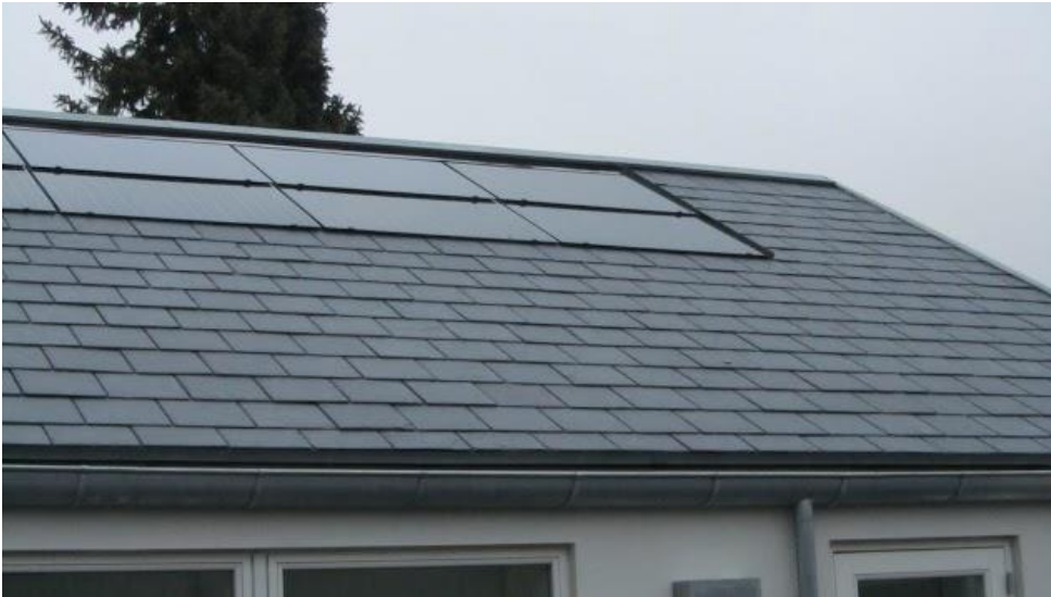
Flintager hus i Albertslund, solceller i skifertag, Saint Gobain leverede solcellerne.
