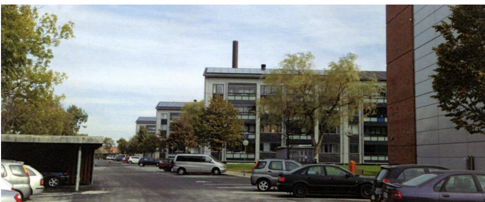
Hornemanns Vænge i Valby med 85 kWp solceller (600 m 2 ) til 6 boligblokke. Fungerer sammen med 100 m 2 solfangere på hver boligblok som en "solenergi kraftvarme løsning", der spiller godt sammen med det københavnske kraftvarme system. I solrige perioder om sommeren kan fjernvarmeforsyningen i princippet stoppes.
