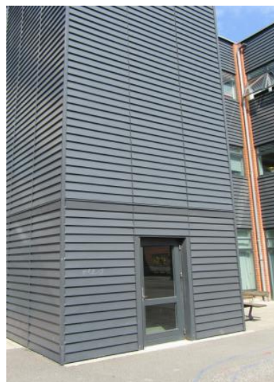
Metalplader mod syd kan delvist erstattes af solceller
