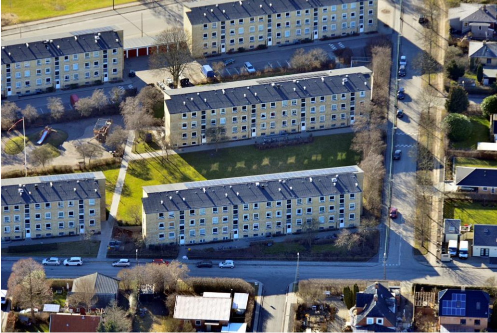
Solceller til Stakhaven i Valby med ca. 70 kWp, blev udført på basis af det fælles elforbrug i bebyggelsen
