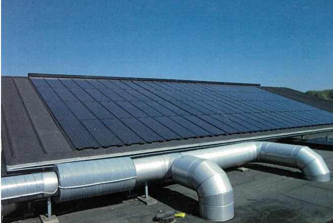
Furesø bad 11,52kWp. 85 m 2 solceller fra Gaia Solar.
