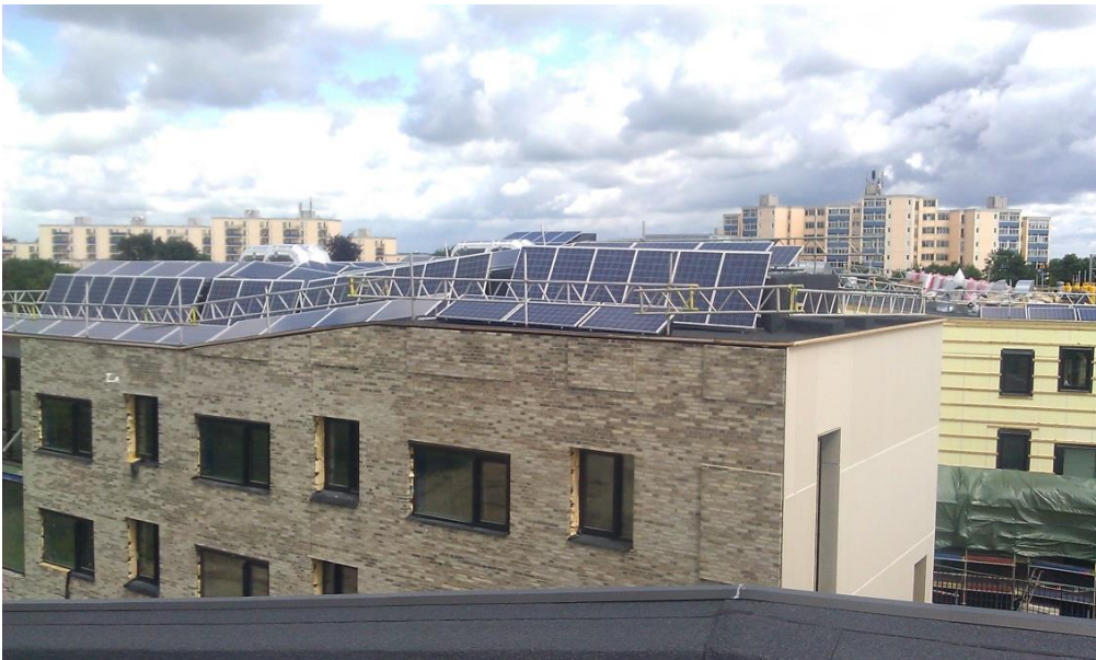
Da ventilation installationer sent i processen blev flyttet til taget, blev der meget lidt plads til solcellerne. Den valgte løsning langs kanten af taget var hverken arkitektonisk eller funktionelt en god løsning.
