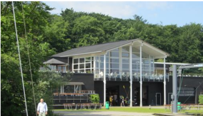
Furesø bad. Solceller blev placeret på tag mellem trekantlister på tagpaptag
