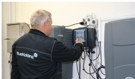
Driftsoperatør indstiller parametre på online målerudstyr
