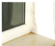
Figur 4.1. Foto af vindue: Misfarvning af tapet i murfals ved vinduesplade.
