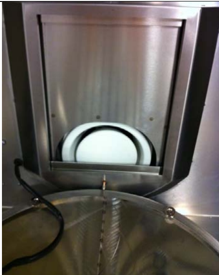
Fedtfilter afmonteret og fugtventilen kommer til syne. Billeder af emhætte konstruktion.
