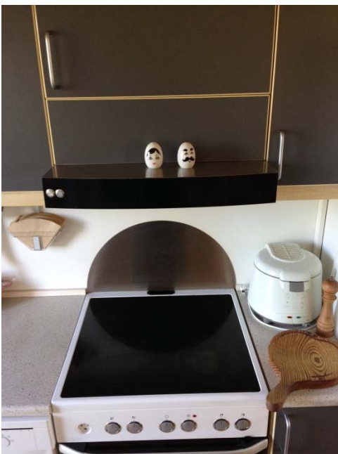
Installeret ny prototype emhætte.
