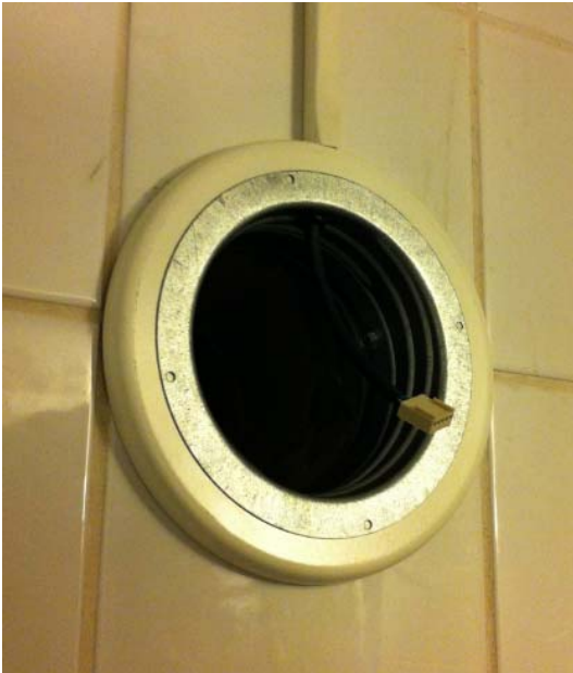
Afslutning af udsugningsrør med flange.
