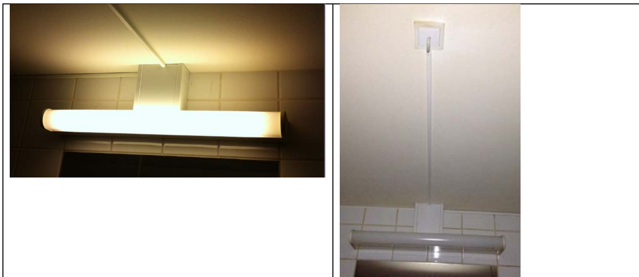
DC strømforsyning er placeret lige over lysarmatur; men forsynes fra kontakt midt i loft. Det bør bemærkes, at nogle el-installationer afbryder for strømmen når lyset slukkes. Hvis det er tilfældet, hvor skal strømmen så tages fra?
