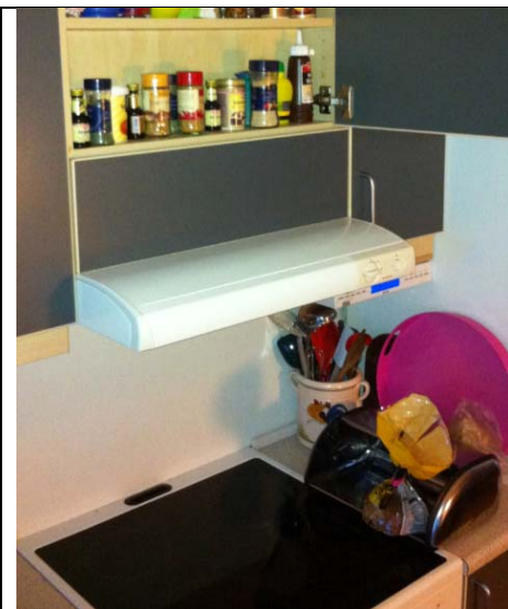
Eksisterende emhætte med mulighed for forcering af luftmængde.
