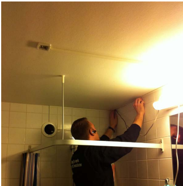
Der trækkes kabel fra DC strømforsyning til ventil.
