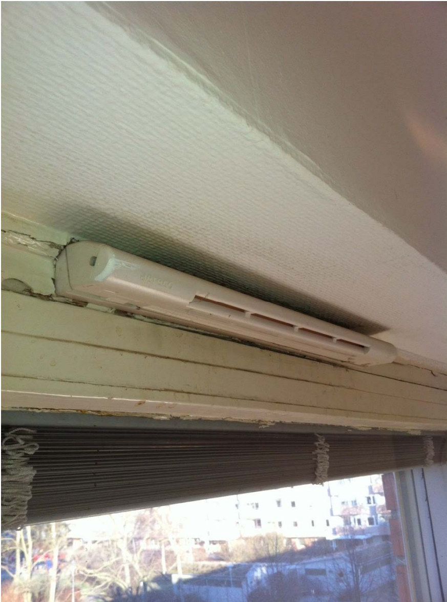
Fugtstyret friskluftventil fra Aereco.
