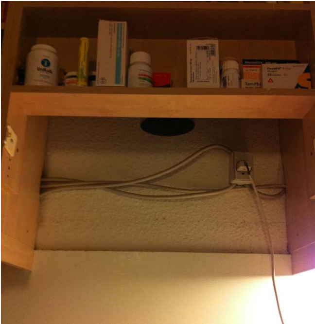
Afmontering af eksisterende emhætte.
