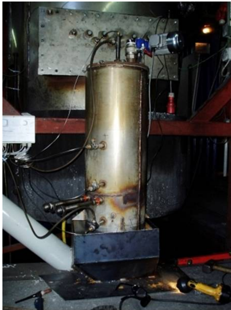
Figur 5: Her ses den lille eksterne forgasser mens den er ved at blive monteret ved bypass forbindelsen ud fra den store gasgenerator i baggrunden.
