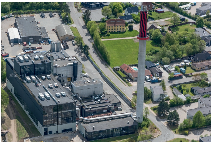
Norfors' kraft-varmeanlæg i Hørsholm skal lægge grund til forsøg med energilagring. Foto: Norfors.
